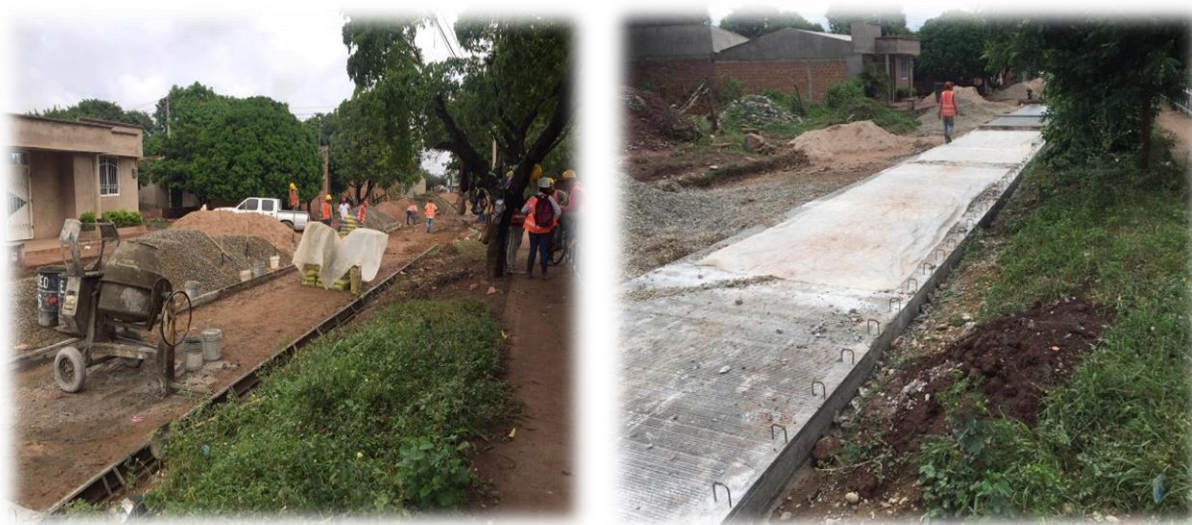
Ilustración 6. Pavimentación. Fuente: (Autor, 2019).
