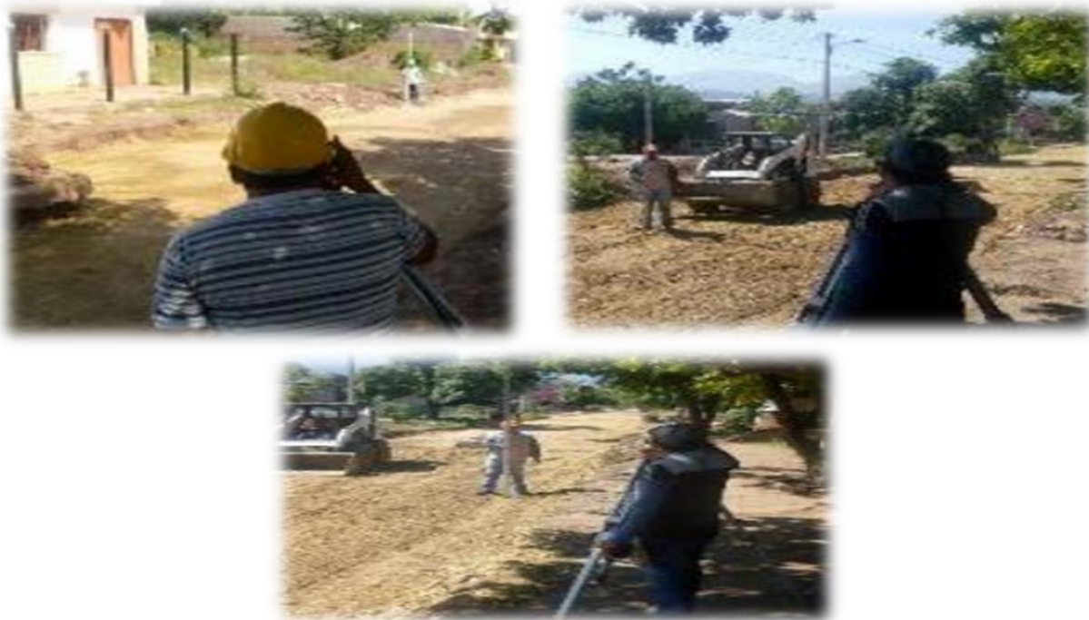
Ilustración 4. Replanteo y toma de niveles subrasante y subbase. Fuente: (Autor, 2019)
