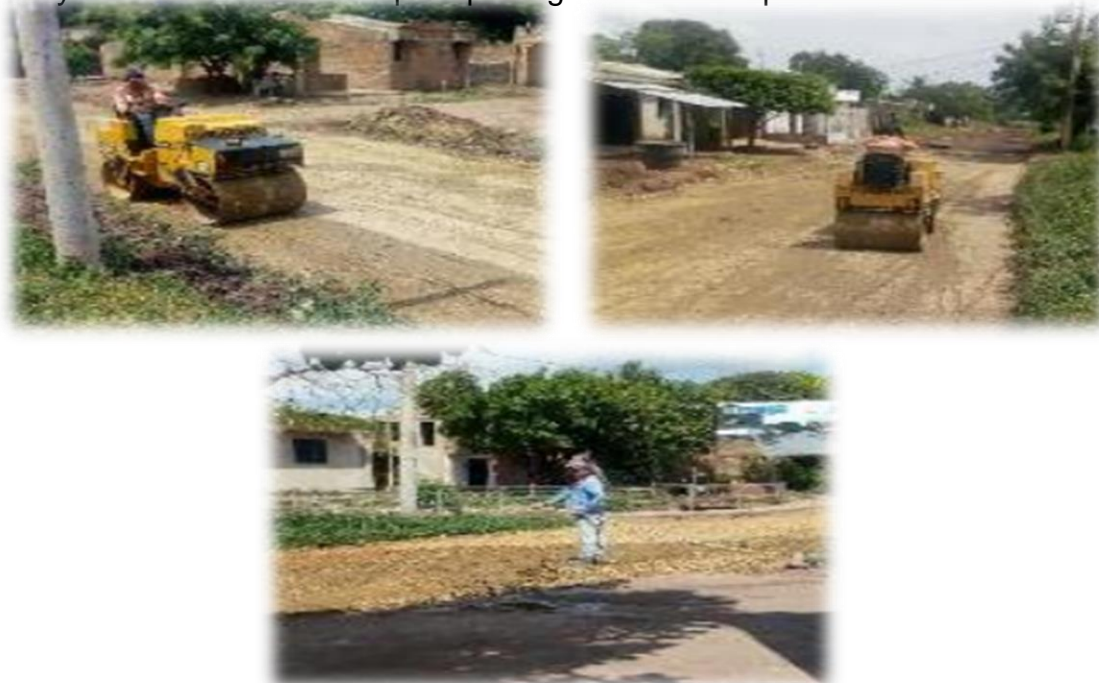
Ilustración 5. Humectación y compactación de subrasante y súbbase. Fuente: (Autor, 2019)
