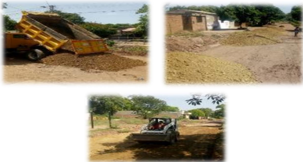
Ilustración 3. Disposición y extendida de material seleccionado. Fuente: (Autor, 2019).
