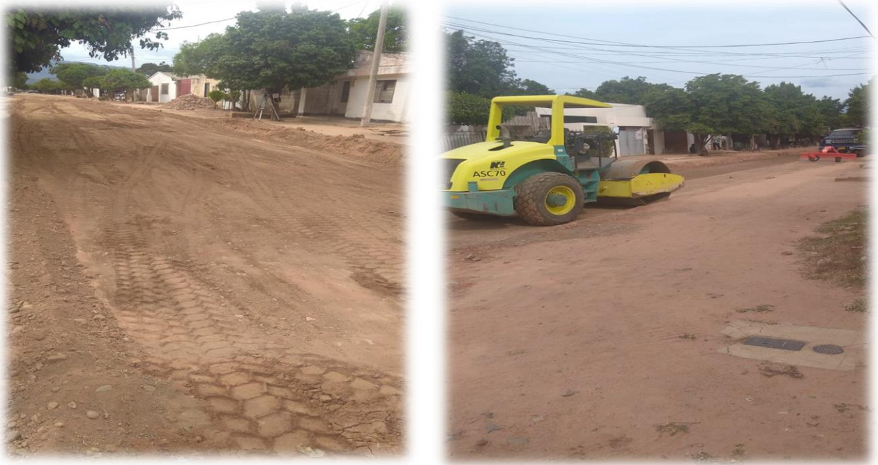
Ilustración 2. Avances generales de la obra. Fuente: (Autor, 2019).
