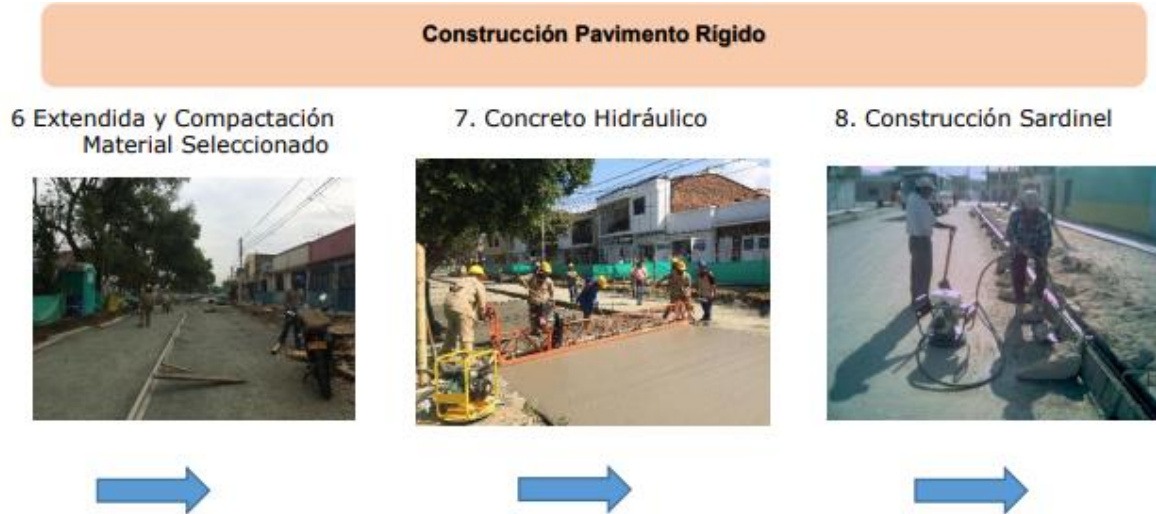
Figura 4. Proceso constructivo pavimento rígido. Fuente: (Proyecto estándar: CONSTRUCCIÓN PAVIMENTO RÍGIDO EN VÍAS URBANAS DE BAJO TRÁNSITO, 20015)
