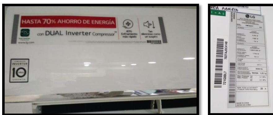
Figura 23 Aire acondicionado y etiqueta R-410A. Fuente: El autor
