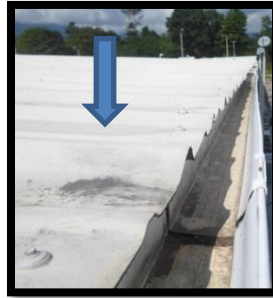
Figura 16 Techo con aislante térmico Sikafill-560 Fuente: El autor
