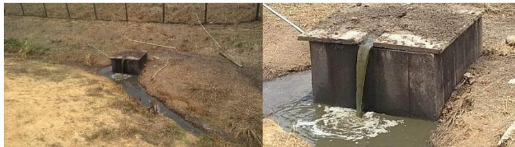
*Ilustración 38. Derrame de agua residual no doméstica por caja externa Sitio IB.*
