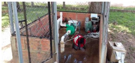
*Ilustración 48. Cinta metrificada con sensor hidrófilo*
