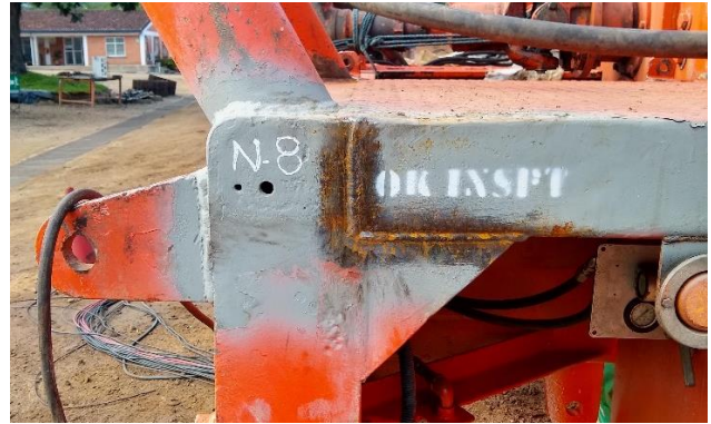
Fisura corregida por soldador Fisura chasis – parte trasera derecha
