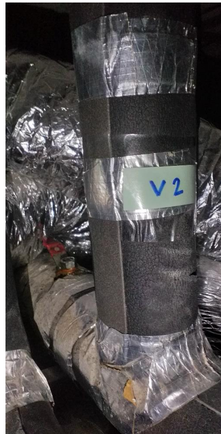
Ilustración 58. Válvulas de suministro de agua fría CHILLER CIRUGÍA CAL
