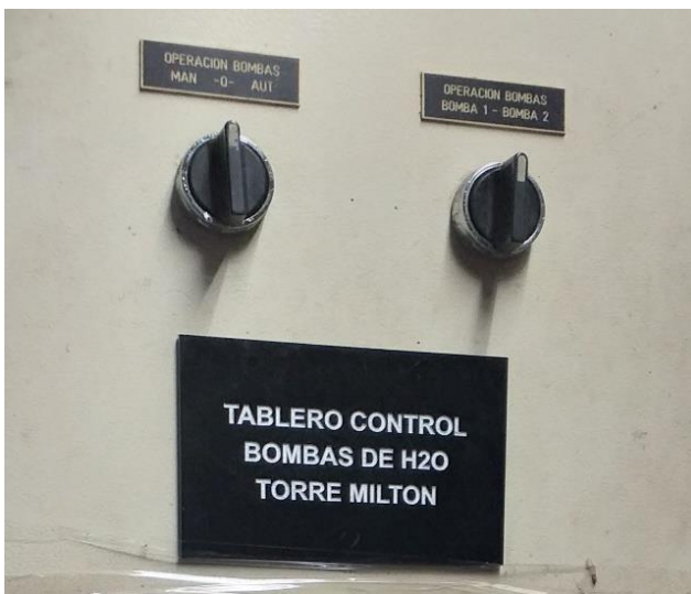
Ilustración 45. Tablero de control bombas de agua potable / válvula mutante de 3 pulgadas CLÍNICA FOSCAL.
