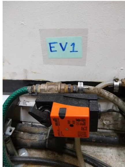
Ilustración 63. Electroválvulas de 3 vías CHILLER RESONANCIA MAGNÉTICA
