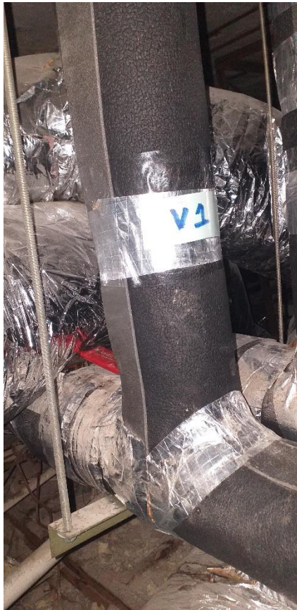
Ilustración 58. Válvulas de suministro de agua fría CHILLER CIRUGÍA CAL
