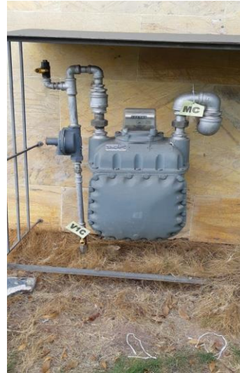
Ilustración 17 Contador de gas y válvula de corte de suministro de gas calderas CLÍNICA FOSCAL INTERNACIONAL
