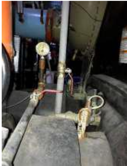
Ilustración 38. Manómetros de línea de evaporación y condensación CHILLER CLÍNICA FOSCAL INTERNACIONAL
