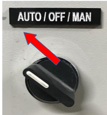
Ilustración 12 Selector de bomba de agua potable CLÍNICA FOSCAL INTERNACIONAL
