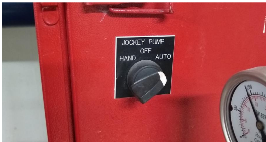
Ilustración 40. Selector de modo de funcionamiento de Bomba JOCKEY CLÍNICA FOSCAL INTERNACIONAL
