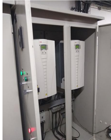
Ilustración 2. Variador de velocidad bomba de agua potable CLÍNICA FOSCAL INTERNACIONAL
