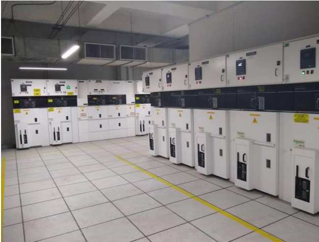
Ilustración 28 Pasillo izquierdo – celdas CLÍNICA FOSCAL INTERNACIONAL
