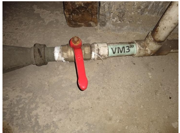
Ilustración 45. Tablero de control bombas de agua potable / válvula mutante de 3 pulgadas CLÍNICA FOSCAL.
