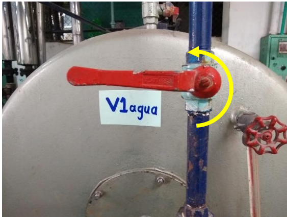
Ilustración 50. Válvula y selector de tanque de condensación caldera CLÍNICA FOSCAL.
