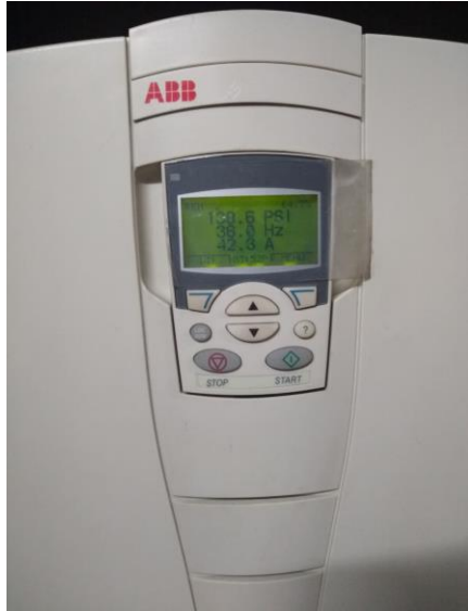
Ilustración 2. Variador de velocidad bomba de agua potable CLÍNICA FOSCAL INTERNACIONAL
