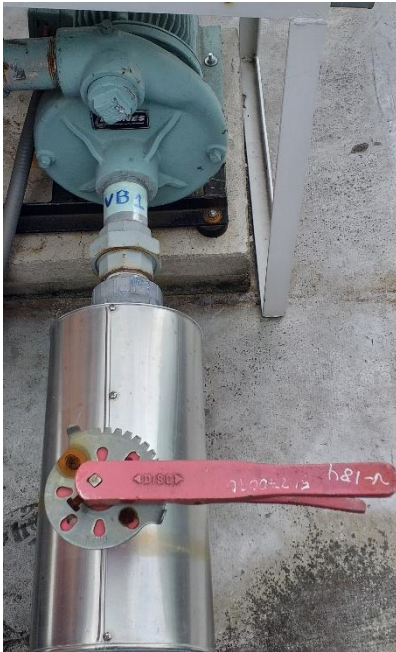
Ilustración 60. Válvulas de paso de bombeo de agua fría CHILLER CIRUGÍA CAL
