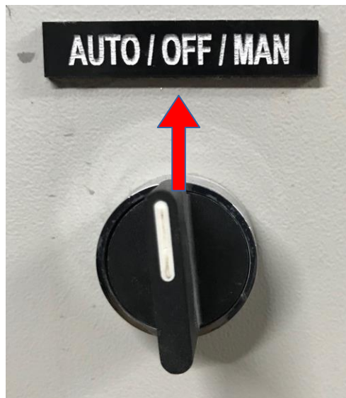
Ilustración 4. Selector de bomba de agua potable CLÍNICA FOSCAL INTERNACIONAL
