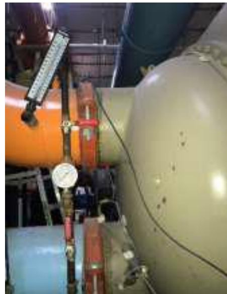
Ilustración 38. Manómetros de línea de evaporación y condensación CHILLER CLÍNICA FOSCAL INTERNACIONAL
