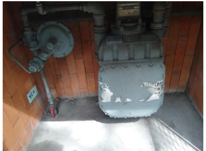
Ilustración 51. Contador externo de gas CLÍNICA FOSCAL.
