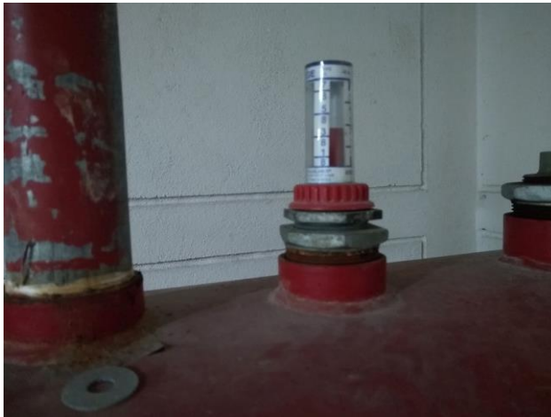
Ilustración 42. Mirilla de nivel de tanque de ACPM/ Filtros de la bomba principal CLÍNICA FOSCAL INTERNACIONAL
