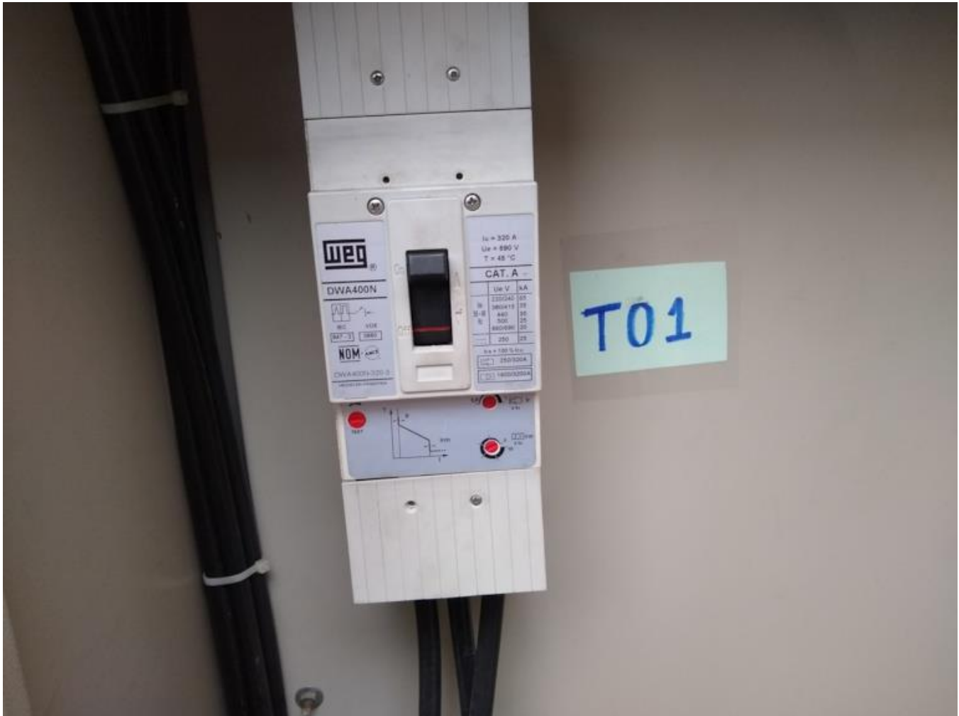
Ilustración 71. Totalizador CHILLER RESPALDO TMS
