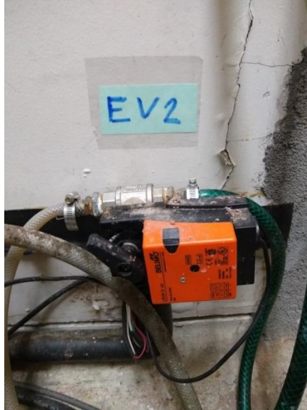
Ilustración 63. Electroválvulas de 3 vías CHILLER RESONANCIA MAGNÉTICA
