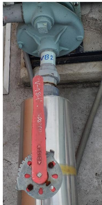
Ilustración 60. Válvulas de paso de bombeo de agua fría CHILLER CIRUGÍA CAL
