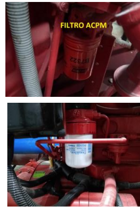
Ilustración 42. Mirilla de nivel de tanque de ACPM/ Filtros de la bomba principal CLÍNICA FOSCAL INTERNACIONAL
