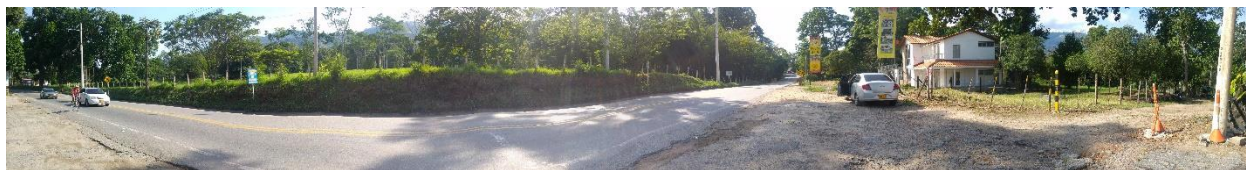
Ilustración 18. Estado de la vía Piedecuesta – Curos (punto El Bwey)
