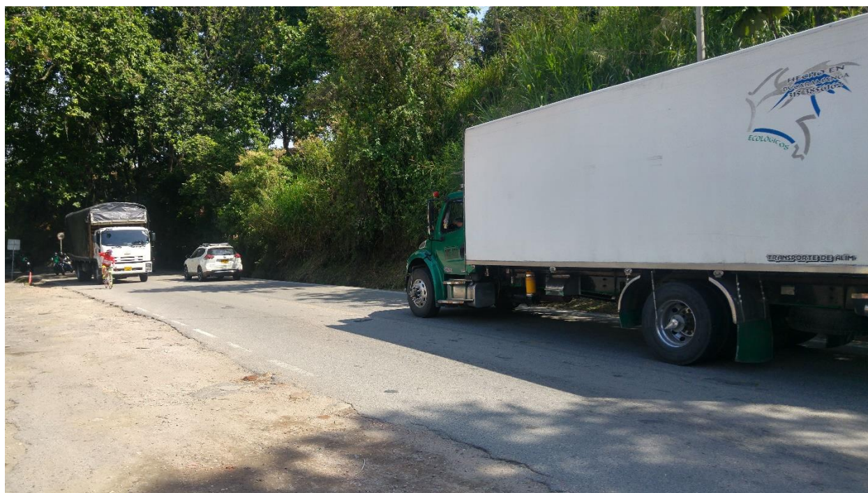
Ilustración 23. Estado de la vía Piedecuesta – Curos (punto Quijanos)
