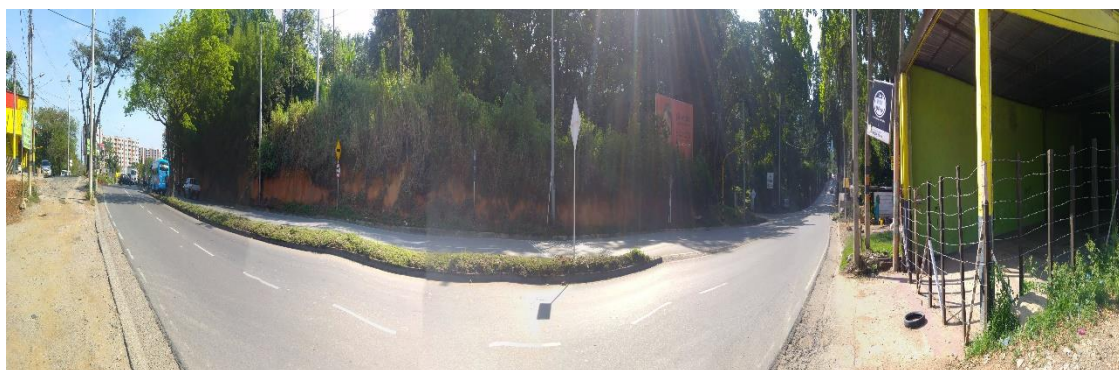
Ilustración 17. Estado de la vía Piedecuesta – Curos (punto Paseo del Puente)
