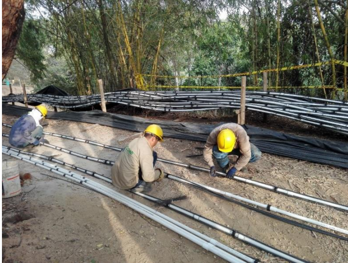
Imagen 17 Armado de anclajes
