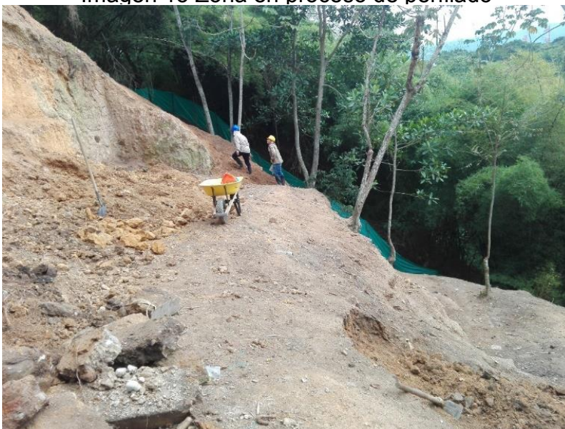
Imagen 15 Zona en proceso de perfilado
