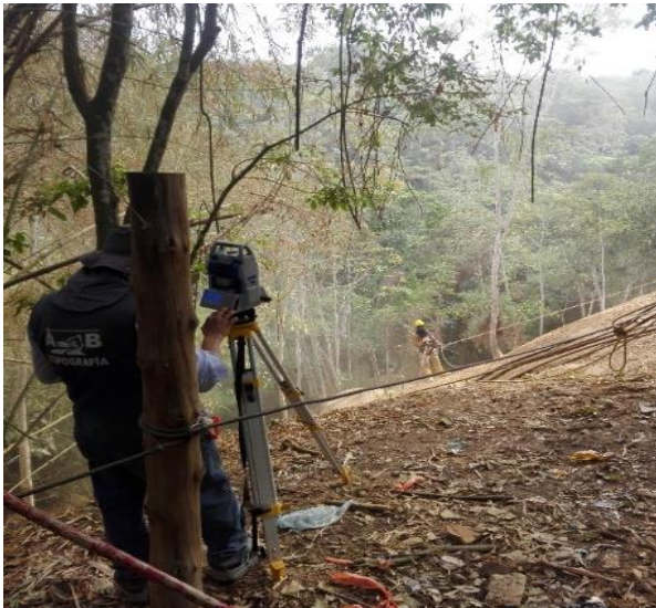
Imagen 22 Replanteo de coordenadas
