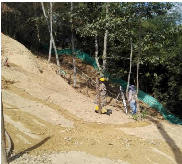
Imagen 23 Seguimiento de replanteo
