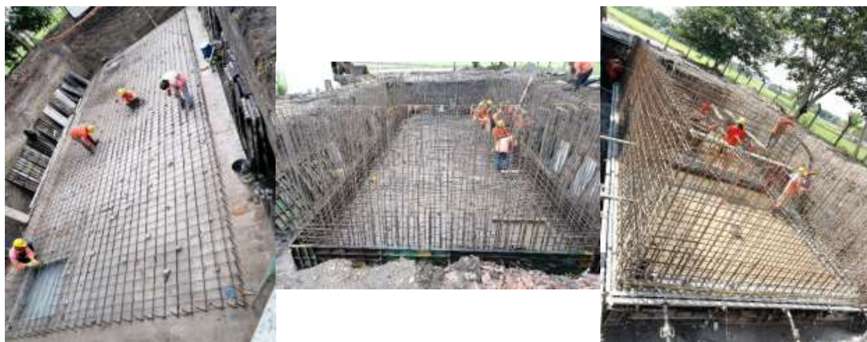
Fig 44. Refuerzo de estructura tanque de almacenamiento. Fuente. propia
