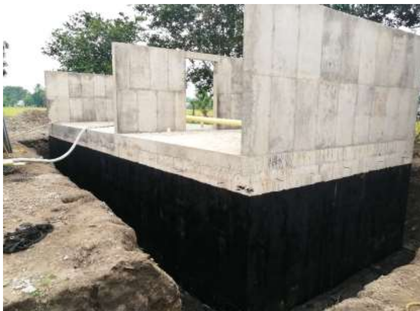
Fig 47. Aplicación de impermeabilizante. Fuente. Propia.
