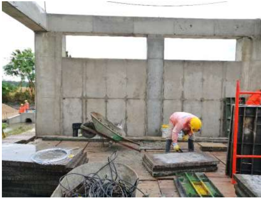
Fig 37. Pantallas en proceso de fraguado. Fuente. Propia
