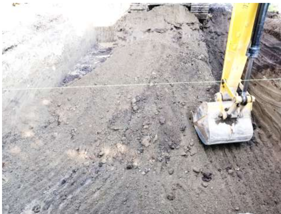
Fig 42. Excavación de la zona para el tanque de almacenamiento. Fuente. Propia
