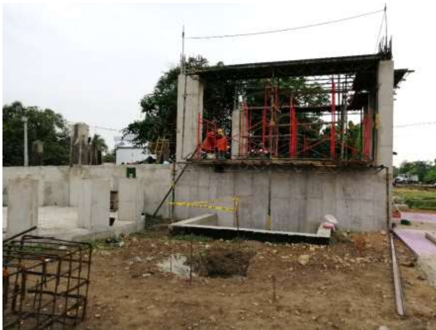
Fig 9. Condiciones iniciales zona de pre-limpieza y secado y rampa de descargue de tolvas. Fuente. Propia.
