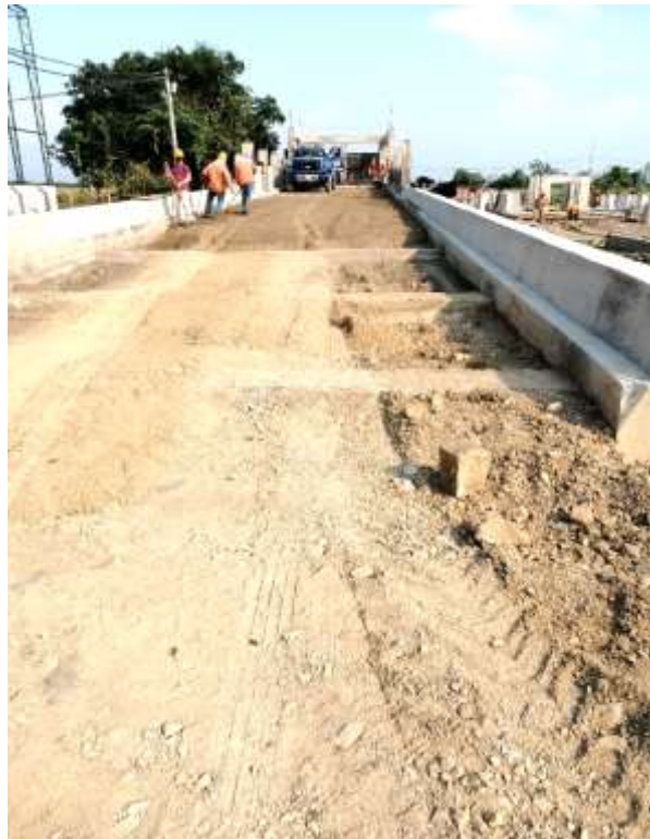
Fig 38. Perfilación y replanteo zona rampa de descargue de tolvas. Fuente. Propia
