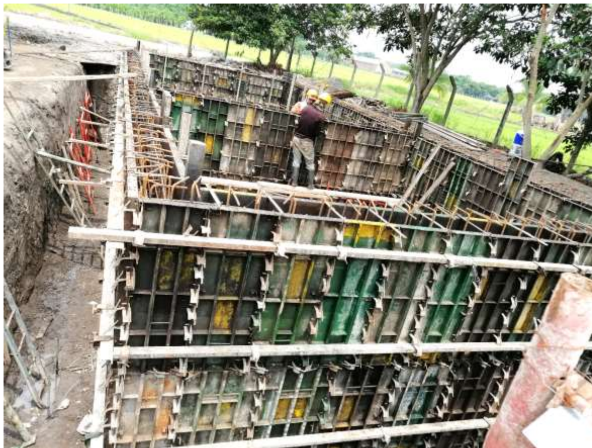
Fig 45. Instalación de formaleta para tanque de almacenamiento. Fuente. Propia
