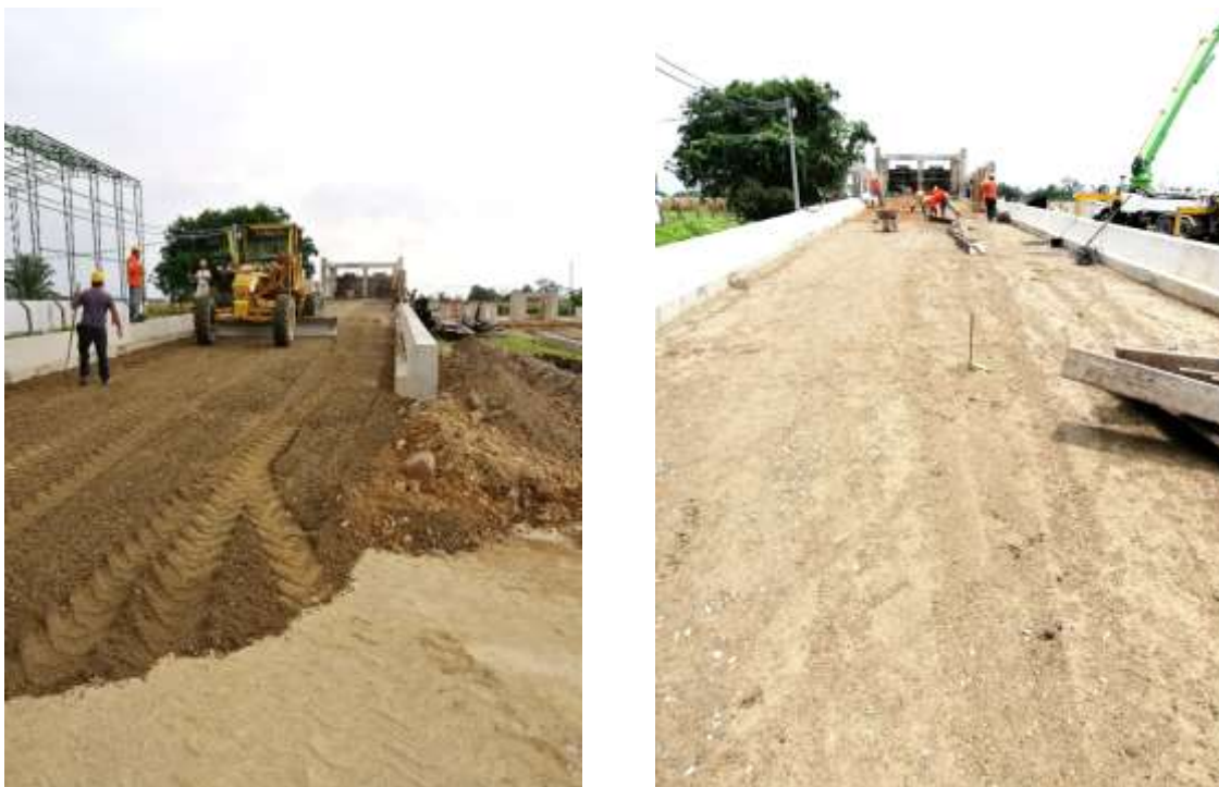
Fig 39. Relleno y compactación zona rampa de descargue de tolvas. Fuente. Propia
