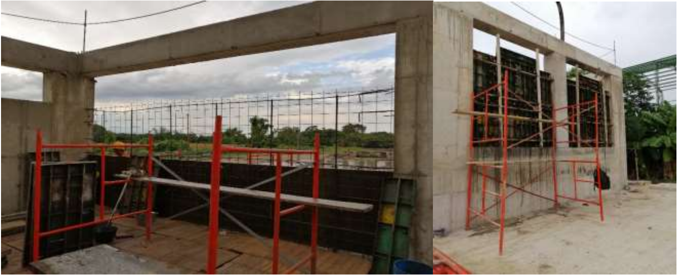
Fig 36. Instalación de formaletas para pantallas laterales. Fuente. Propia
