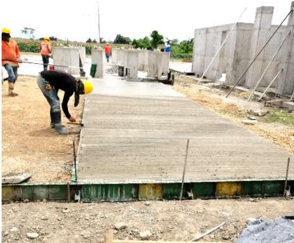
Fig 33. Fundida de andenes. Fuente. Propia
