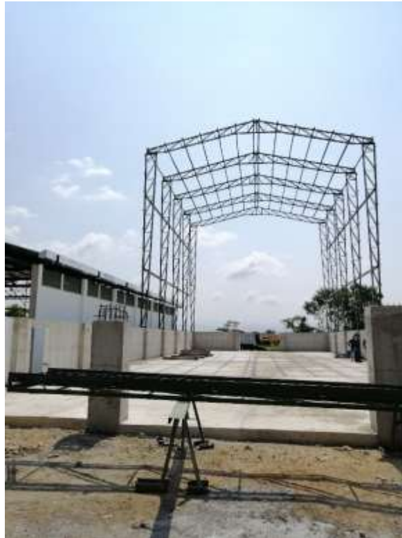
Fig 10. Condiciones iniciales bodega de trilla. Fuente. Propia.
