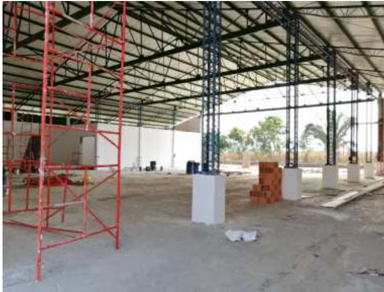
Fig 11. Condiciones iniciales bodega de producto terminado. Fuente. Propia.
