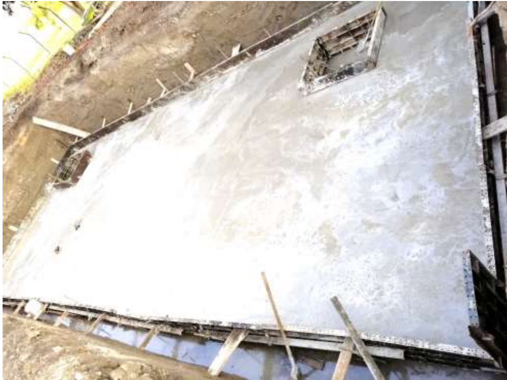
Fig 43. Cimentación con concreto ciclópeo. Fuente. Propia
