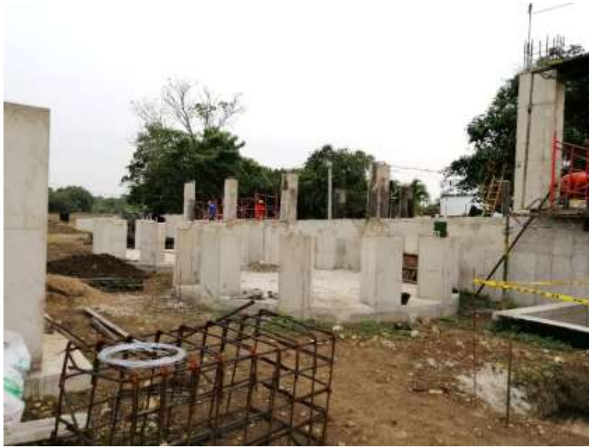
Fig 8. Condiciones iniciales zona de pre-limpieza y secado. Fuente. Propia.
