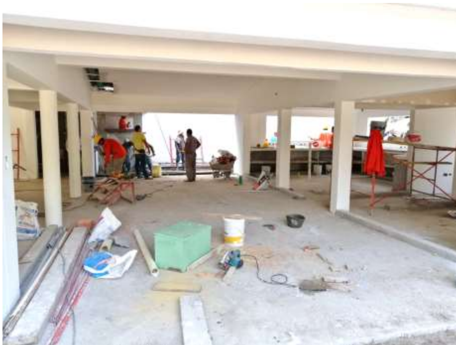
Fig 13. Condiciones iniciales edificio de administración. Fuente. Propia.
