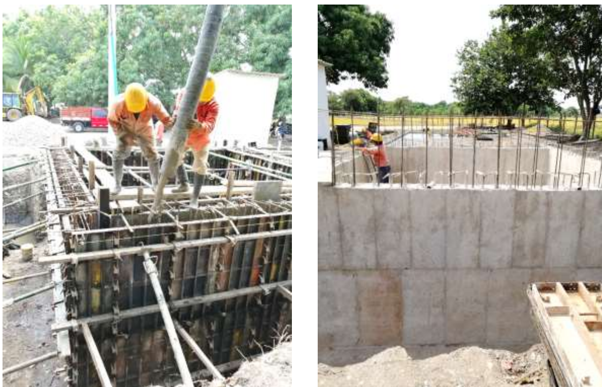
Fig 46. Vaciado de concreto y desencofrado de formaleta. Fuente. Propia
