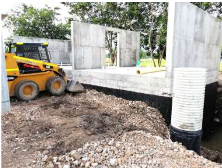
Fig 49. Relleno zona perimetral zona tanque de almacenamiento. Fuente: propia
