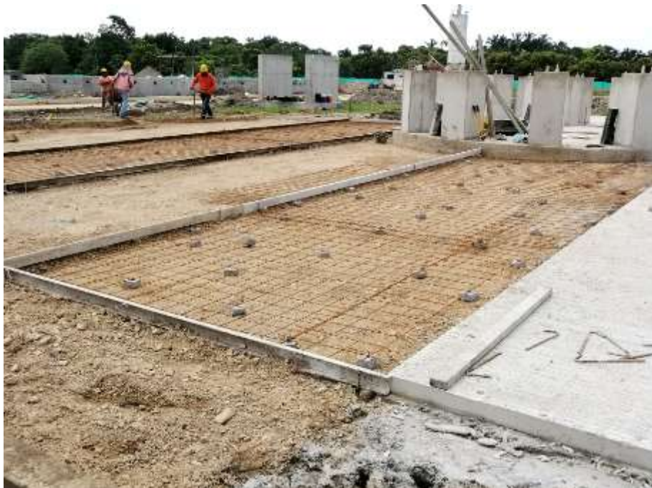
Fig 32. Instalación malla de refuerzo. Fuente. Propia
