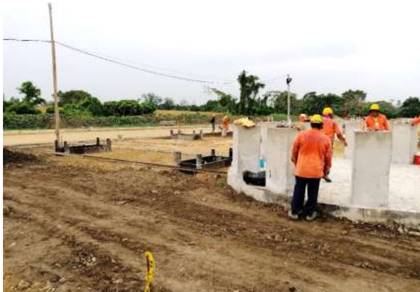
Fig 7. Condiciones iniciales zona de pre-limpieza y secado. Fuente. propia
