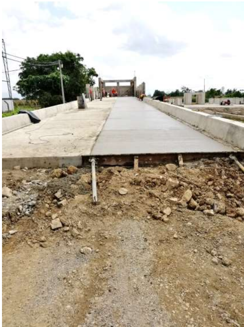
Fig 41. Fundida de rampa para descargue de tolvas. Fuente. Propia
