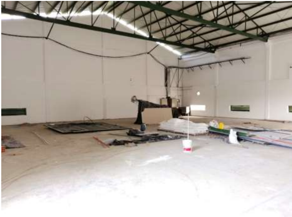
Fig 12. Condiciones iniciales bodega de sub-productos. Fuente. Propia.
