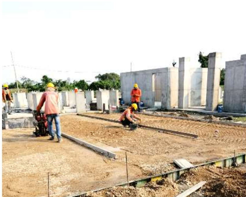
Fig 31. Instalación formaletas para andenes. Fuente. Propia.
