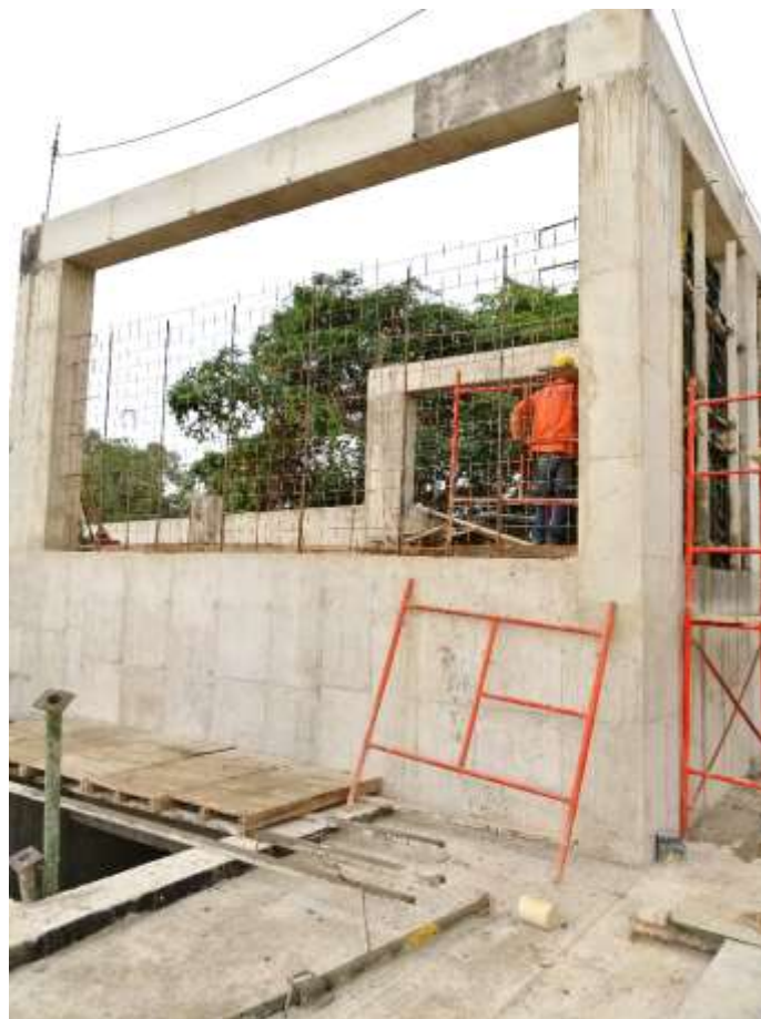
Fig 35. Instalación malla de refuerzo para pantallas laterales. Fuente. Propia
