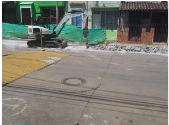
b) Alquiler de Mini retroexcavadora para rotura de losas en concreto
