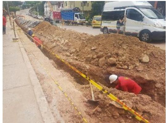
b) Excavación tramo final para tubería de 16"
