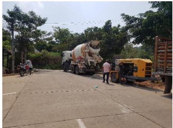
b) Aplicación de concreto hidráulico mediante bombeo
