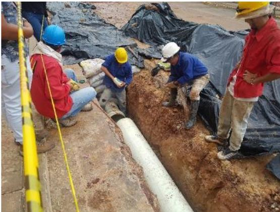
a) Empalme de tubería 16" mediante campana
