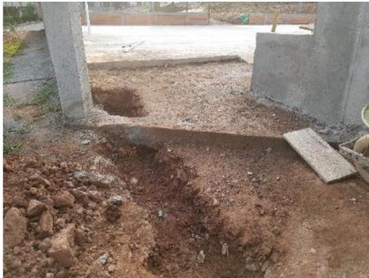
a) Excavación para construcción de caja de recolección y tubo de drenaje de 8"
