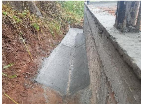
b) Adecuación y fundida de cuneta perimetral de polideportivo para manejo de aguas proveniente del drenaje del terreno aledaño
