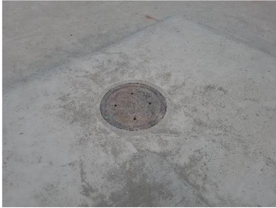
c) Suministro e instalación de tapa con aro para poso de inspección
