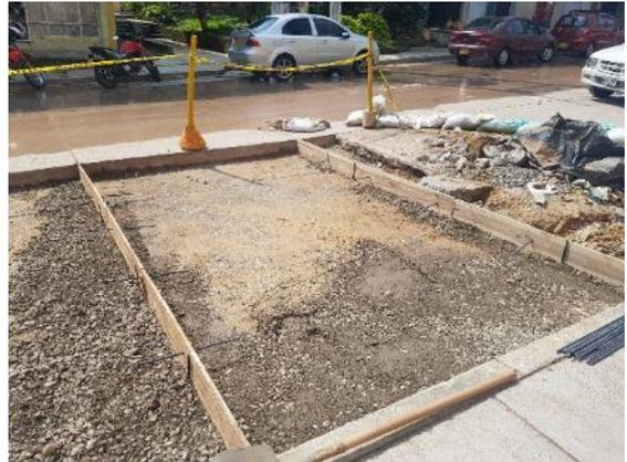
b) Armado de formaleta en tablón de madera para losas de concreto 3 x 5 metros
