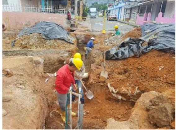
b) Excavación y protección de material con plástico negro contra lluvia
