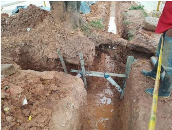
a) Empalme de tubería que interfería en el trayecto de la nueva tubería de 16"
