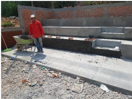
c) Aplicación de mortero para pulida de gradería
