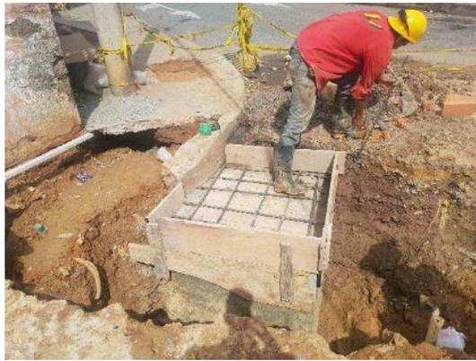
a) Figurado de acero para tapa de pozo válvula de 8"
