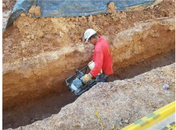
d) Compactación de material común para instalación de tubería
