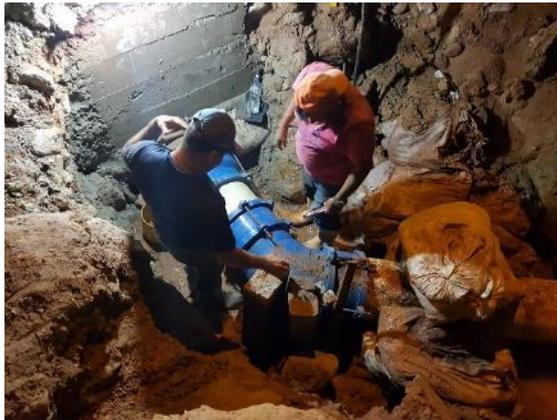
c) Empalme de tubería 16" asbesto con válvula.
