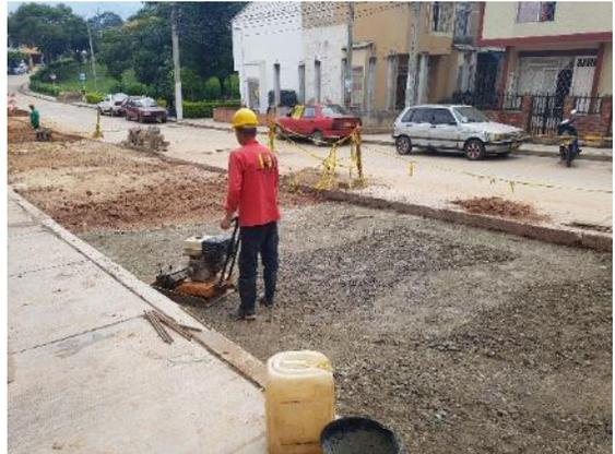
b) Suministro y compactación de base granular con Vibrocompactadora
