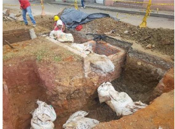
d) Protección de tubos con sacos y tierra expuestos a ruptura
