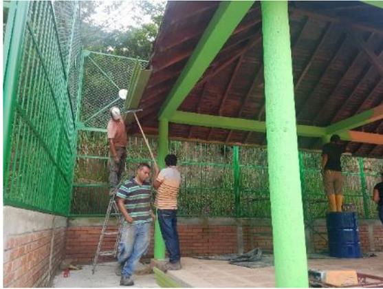
c) Suministro, instalación y pintura de canal en lámina galvanizada calibre 18
