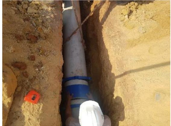
b) Conexión mediante uniones R1 y empaques de 16"
