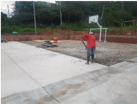
a) Aplicación, extendido y compactación de base granular
