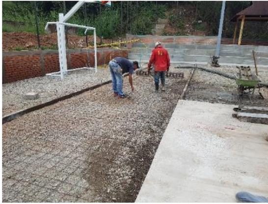
c) Armado de formaleta e instalación de malla metálica para refuerzo
