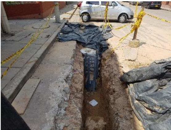
a) Instalación de tapón 16” y atraque con ángulos, costales y alambrón, para prueba hidráulica
