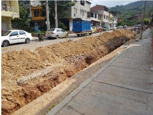
a) Excavación primer tramo para tubería de 16"
