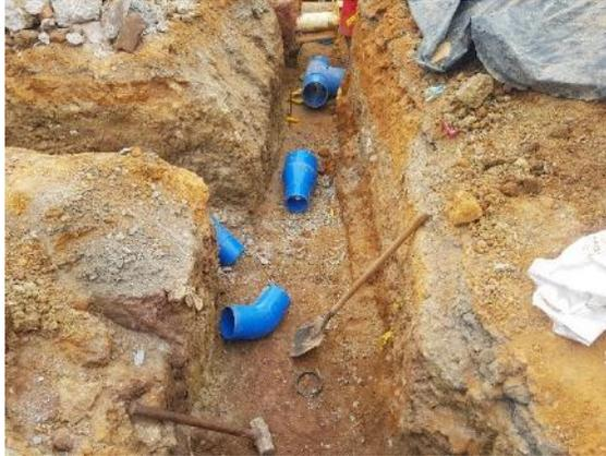
a) Identificación de accesorios a instalar en hierro dúctil (codos, TEE's, reducciones)
