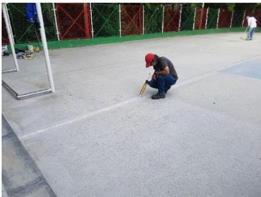
a) Suministro y aplicación de Sikaflex para juntas de construcción
