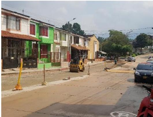
a) Compactación de base granular con rodillo compactador vibratorio
