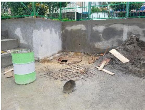
a) Figurado de malla en acero para refuerzo de pozo de inspección
