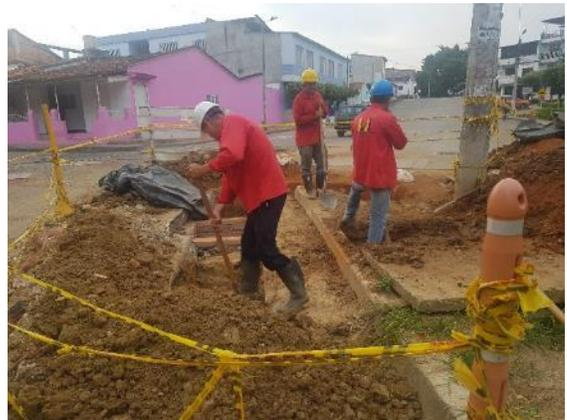
b) Inicio de excavación en zona de empalme de tuberías 12", 8" y 6"
