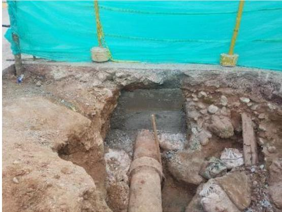
c) Atraque de tubería 16" en concreto de 2000 psi
