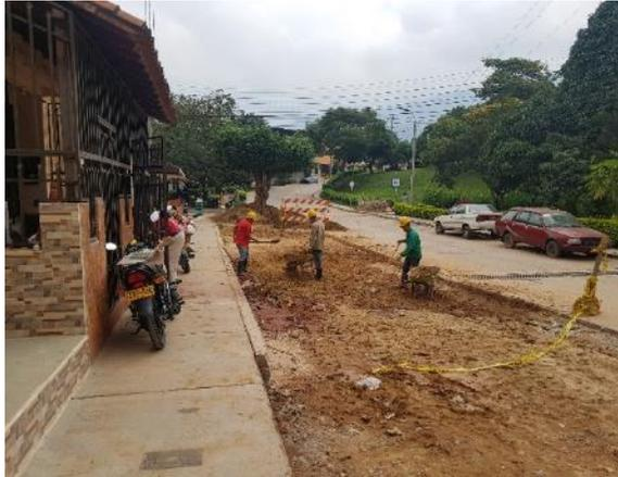
a) Mejoramiento de subrasante mediante el remplazo de tierra húmeda o en malas condiciones
