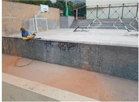
b) Rallado y punzado de muro exterior para aplicación de mortero
