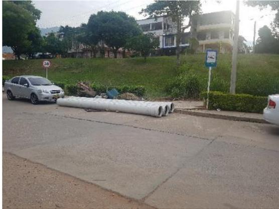
a) Tubería de PVC RDE 21 diámetro 16"
