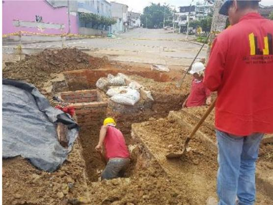
c) Excavación de 1,5 metros de ancho para empalmes
