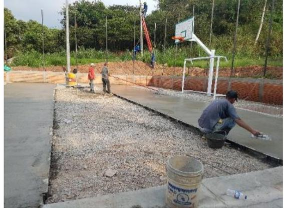
d) Fundida de losas en concreto mediante el método de hileras intercaladas
