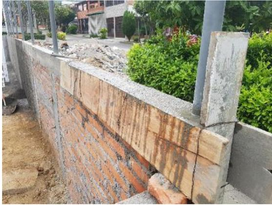
a) Armado y fundida de vigas en concreto
