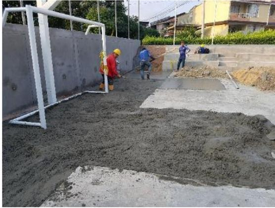
a) Fundida de losas en concreto hidráulico
