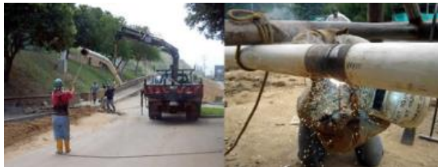
Imagen 8. Construcción de gasoducto
