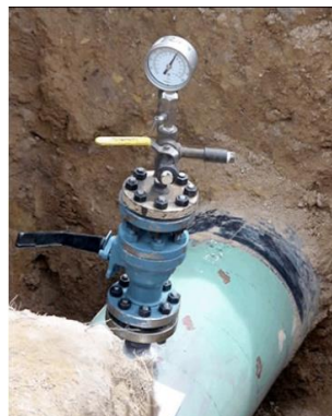
Imagen 6. Conexión HOT TAP
