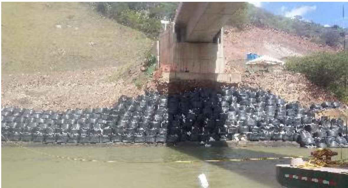
foto 4: Estribo izquierdo puente Geo Von Lengerke.
