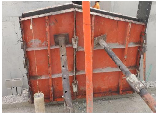
Fotografía 9 Verificación plomos de cuchillas Villas del Duruelo.
