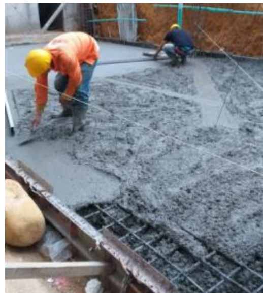
Fotografía 12 Apoyo en supervisión de fundida de cimentación de portería del proyecto Reserva del Rosario
