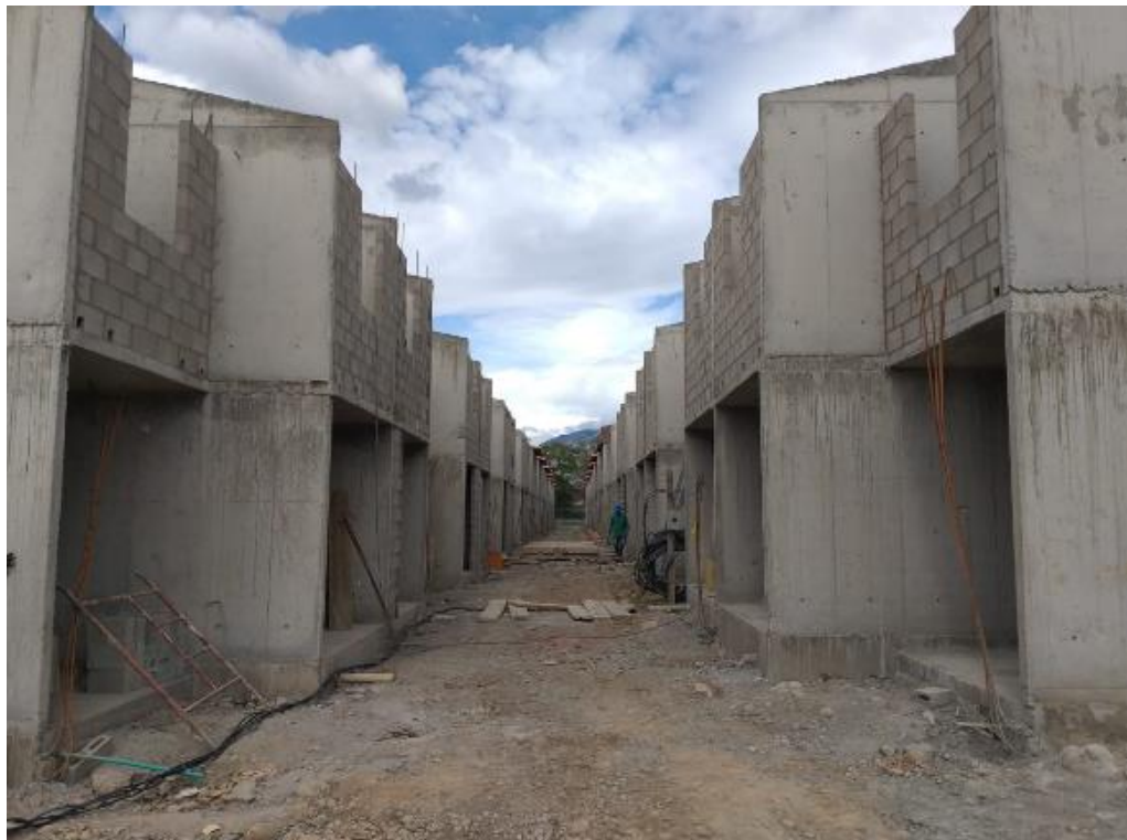
Fotografía 1 Estructura Culminada Manzana C Villas del Duruelo
