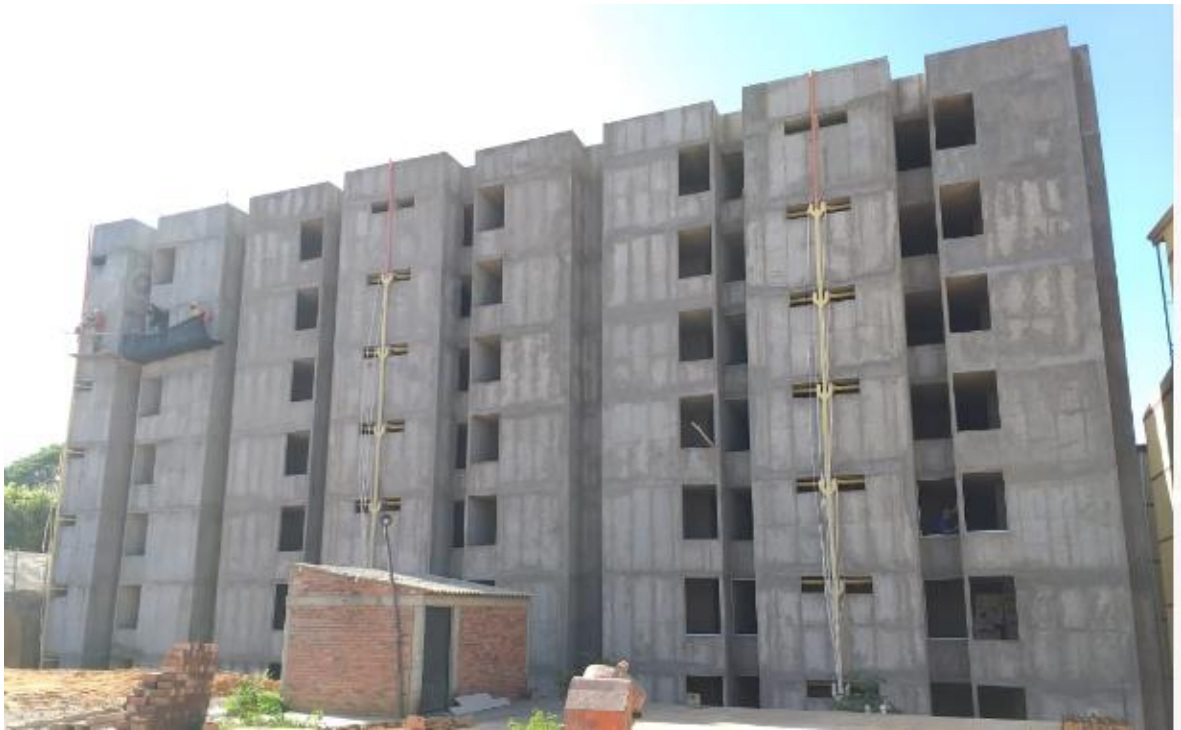
Fotografía 2 Estructura Finalizada Torre D Reservas del Rosario
