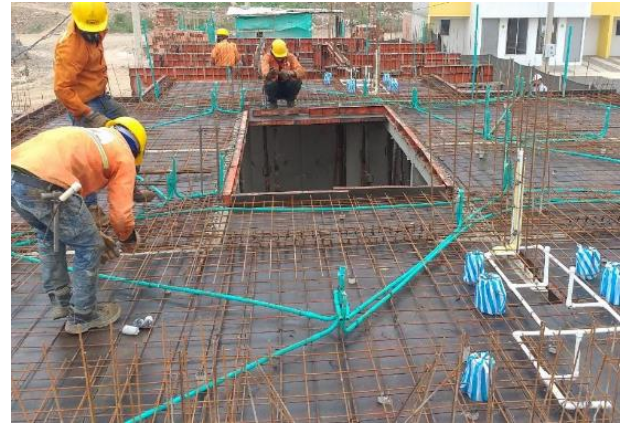
Fotografía 6 Verificación refuerzo para Placa de Entrepiso Villas del Duruelo.
