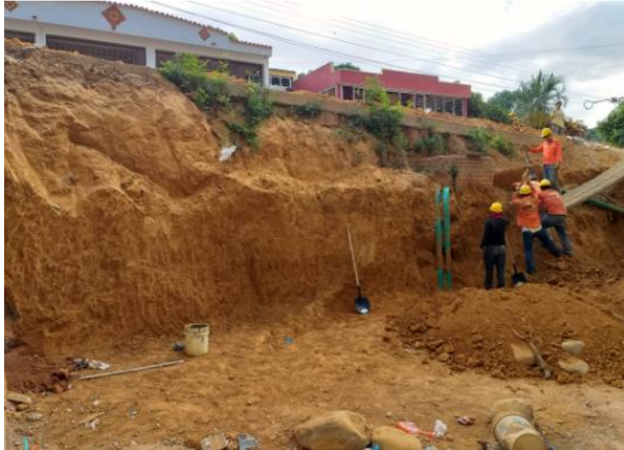
Fotografía 10 Supervisión en excavación y replanteo de terreno para cimentación de portería del proyecto Reserva del Rosario.
