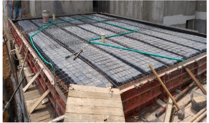
Fotografía 20 Verificación casetones de placa cubierta de portería de la obra Reserva del Rosario.
