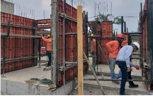
Fotografía 7 Verificación Plomo de Muros Villas del Duruelo.
