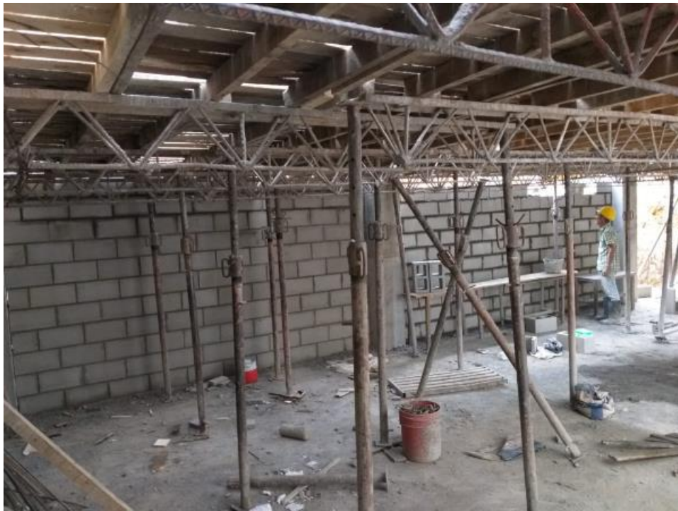
Fotografía 15 Verificación armado muro de contención portería del proyecto Reserva del Rosario.
