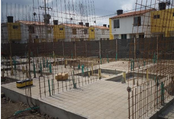
Fotografía 5 Verificación Refuerzo para Muros del proyecto Villas del Duruelo
