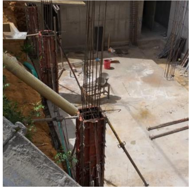
Fotografía 14 Verificación plomo de columnas de primer nivel portería del proyecto Reserva del Rosario.
