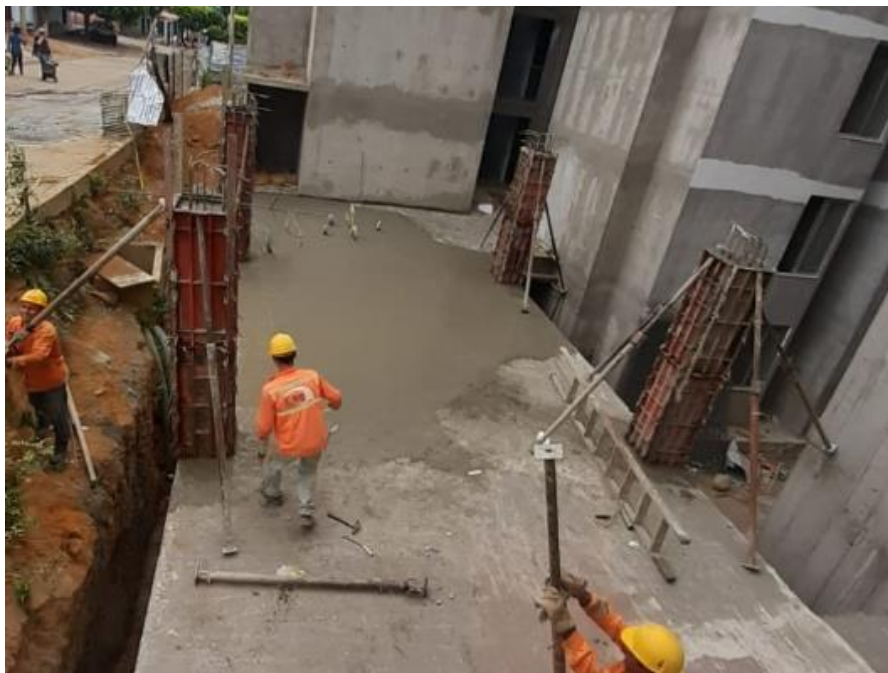
Fotografía 18 Verificación Plomos de columnas de segundo nivel de la portería del proyecto Reserva del Rosario.
