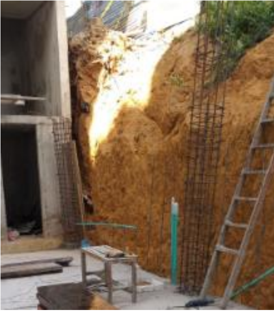
Fotografía 13 Verificación acero de refuerzo para columnas de portería del proyecto Reserva del Rosario.
