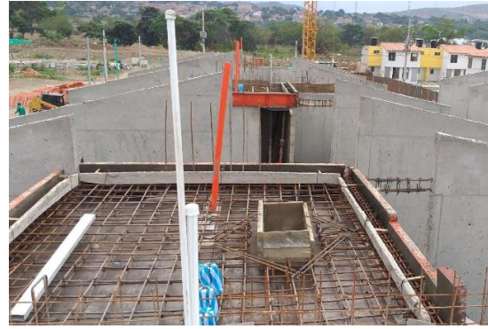
Fotografía 8 Verificación acero de refuerzo Placa Cubierta Villas del Duruelo.
