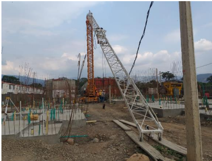
Fotografía 24 Traslado de torre grúa dentro del proyecto Villas del Duruelo.
