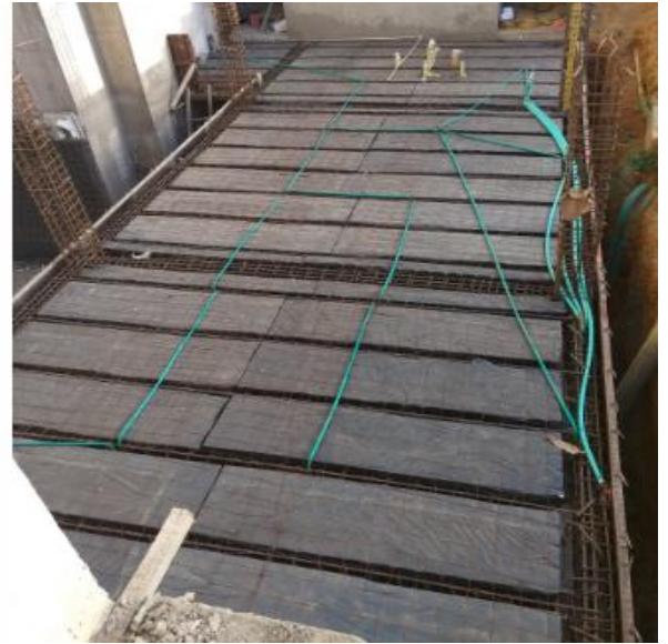
Fotografía 17 Verificación casetones para placa de entrespiso Portería del proyecto Reserva del Rosario.
