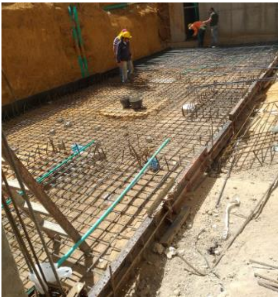
Fotografía 11 Revisión de acero de refuerzo para cimentación de portería del proyecto Reserva del Rosario.
