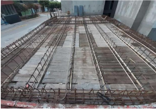
Fotografía 19 Verificación acero de refuerzo de placa cubierta de portería de la obra Reserva del Rosario.
