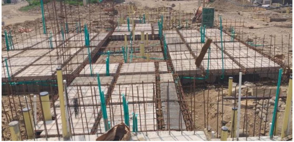
Fotografía 4 Verificación de Ret-cel y Refuerzo de Cimentación del proyecto Villas del Duruelo.
