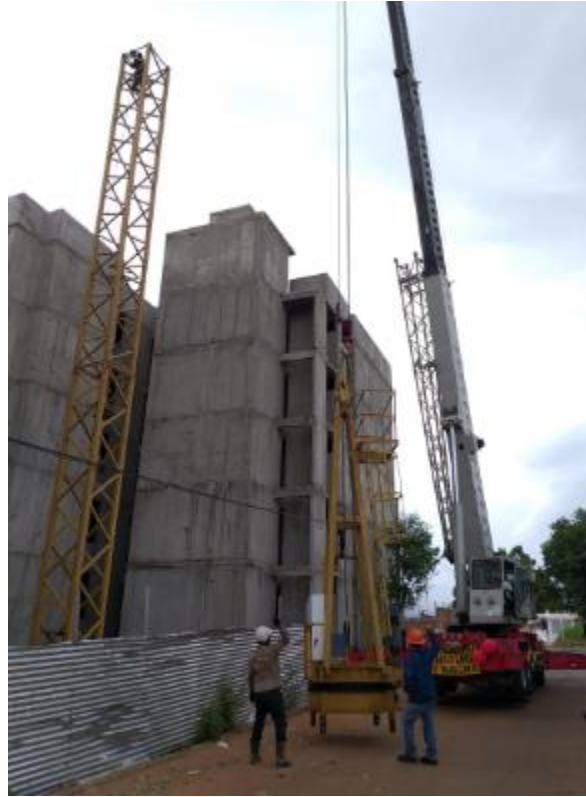
Fotografía 25 Desmonte de torre grúa en el proyecto Reserva del Rosario.
