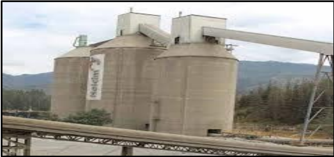
ilustración 12. Silos de almacenamiento de Clinker
