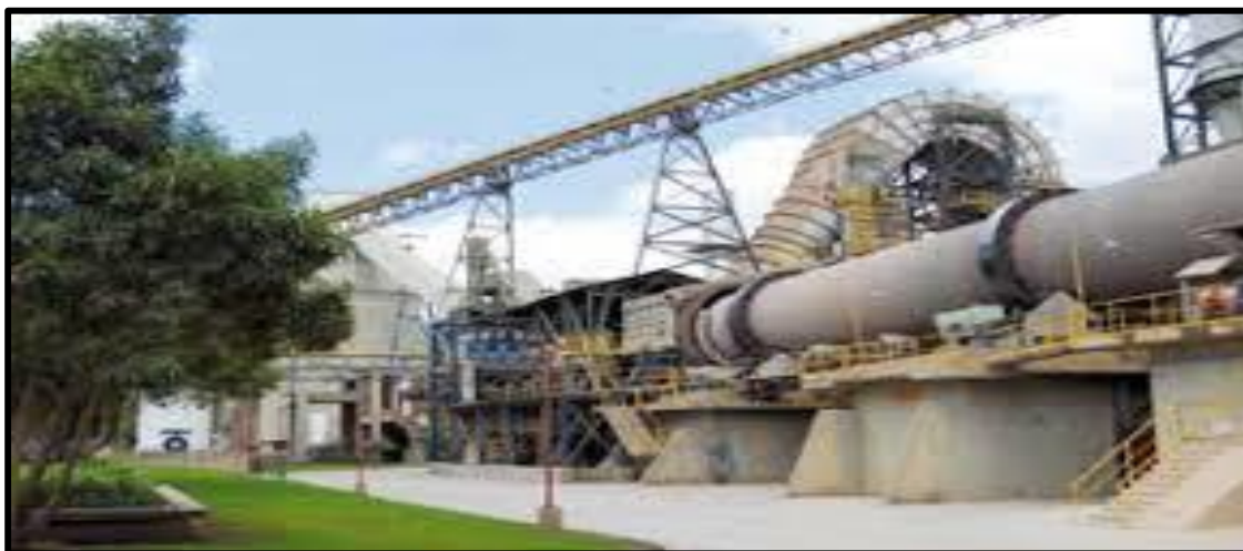
Ilustración 9. Horno giratorio
