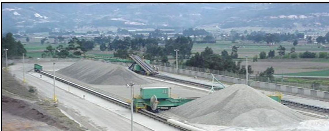
Ilustración 6. Patio de prehomogenización
