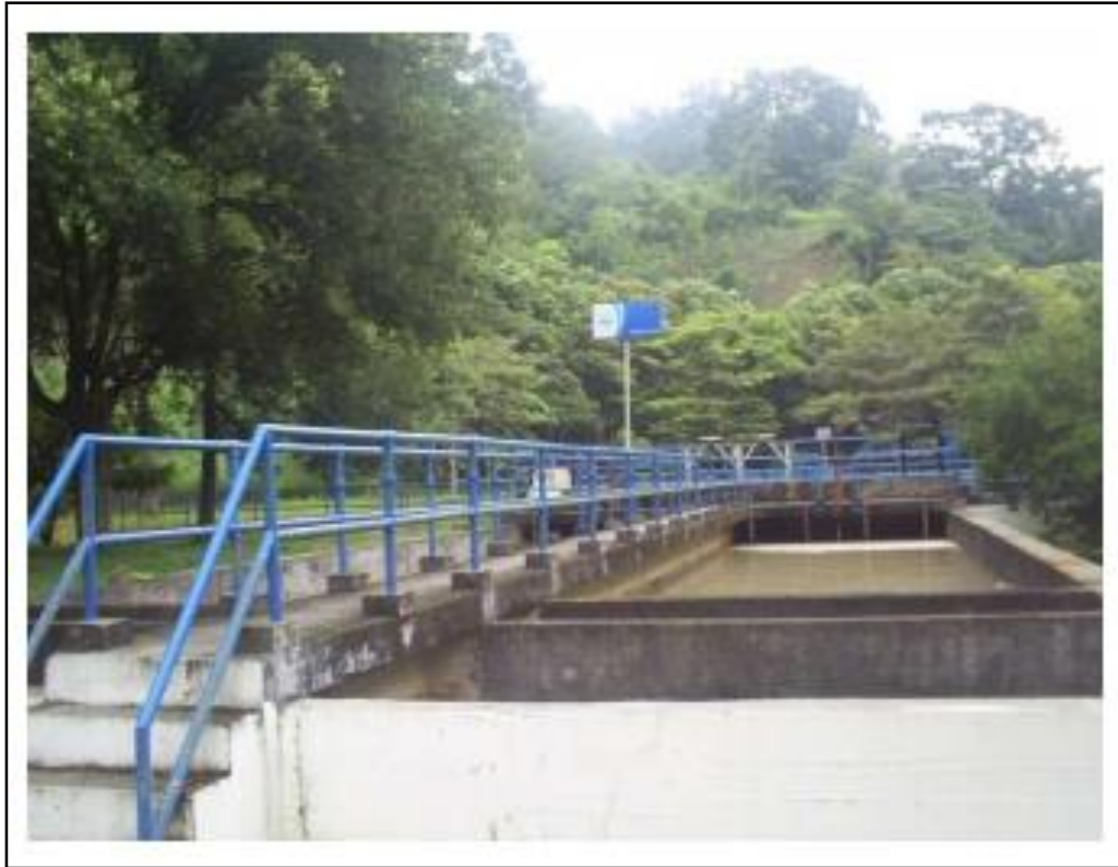
Figura 2. Desarenadores PTAP Bosconia.
