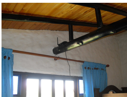
Foto 05. Ubicación del modem dentro de la casa.
