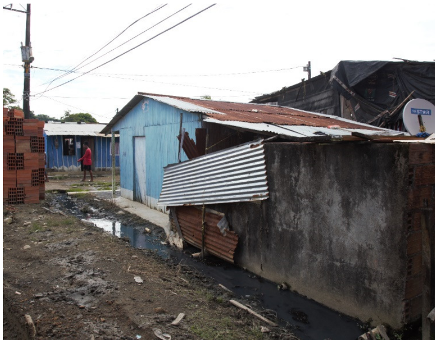
Ilustración 5. Drenaje superficial de aguas residuales (Foto: Nelson Agudelo - UPB)
