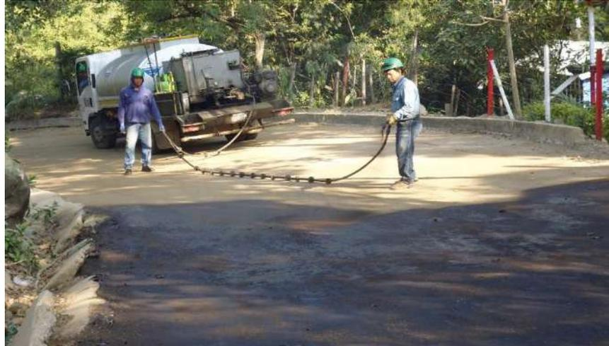
*Imagen 7. Riego de imprimación tipo CRL-1*
