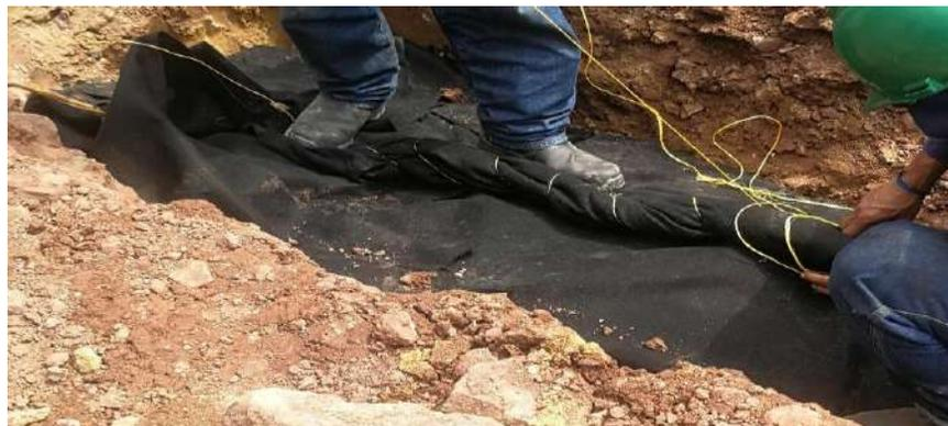
*Imagen 38. Proceso de amarre de geotextil.*
