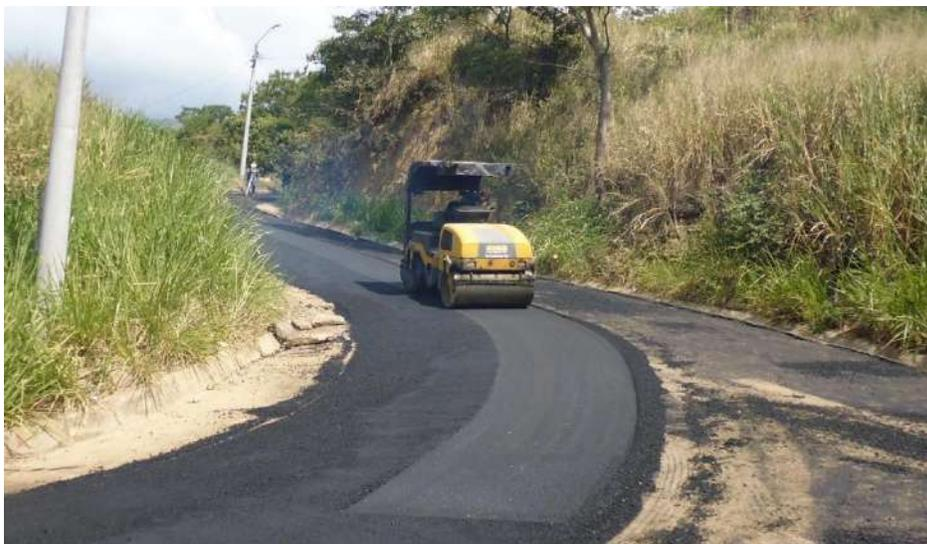
*Imagen 10. Compactación sobre mezcla asfáltica.*
