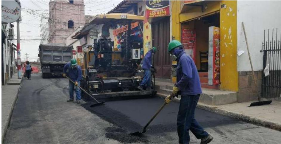
*Imagen 29. Instalación de mezcla asfáltica sobre el daño.*
