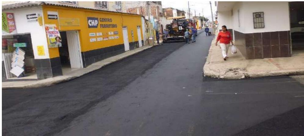
*Imagen 17. Instalación de segunda capa de mezcla asfáltica.*
