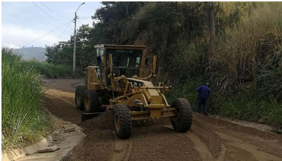
*Imagen 4. Extendido de base granular e=20cm.*
