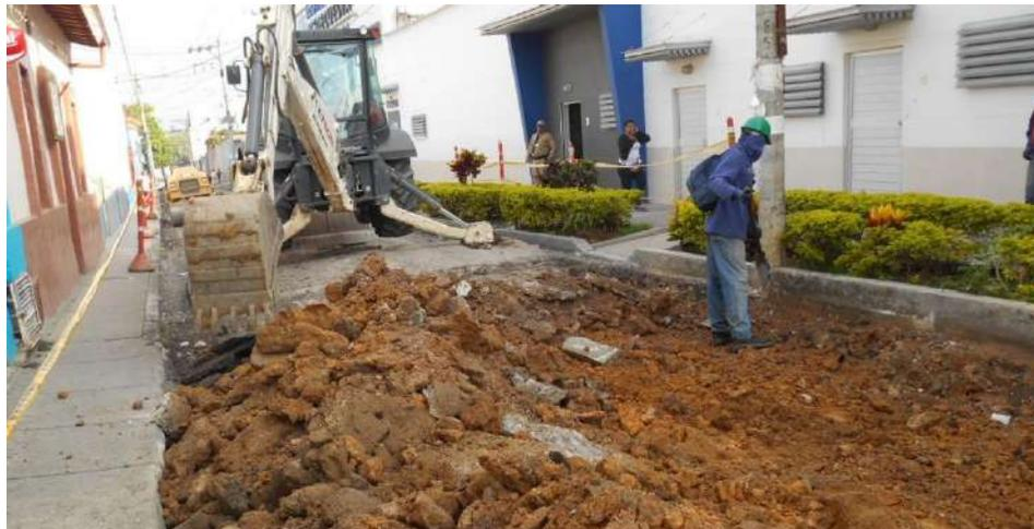
*Imagen 19. Demolición y excavación de pavimento actual.*
