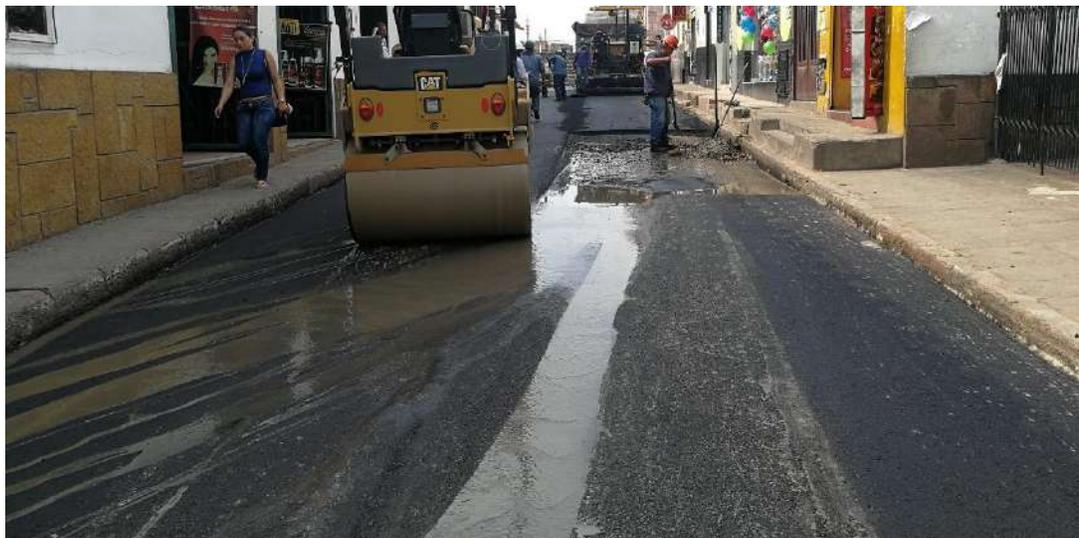
*Imagen 28. Riego de agua por la superficie pavimentada.*
