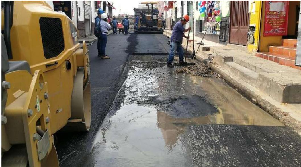
*Imagen 27. Afloramiento de agua debido a daño de tubería de acueducto.*
