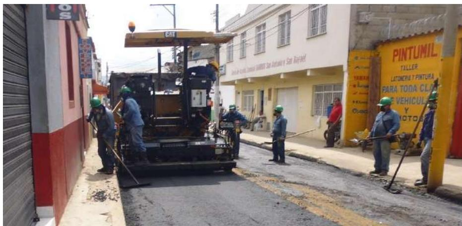
Imagen 15. Instalación de primera tira de mezcla asfáltica.
