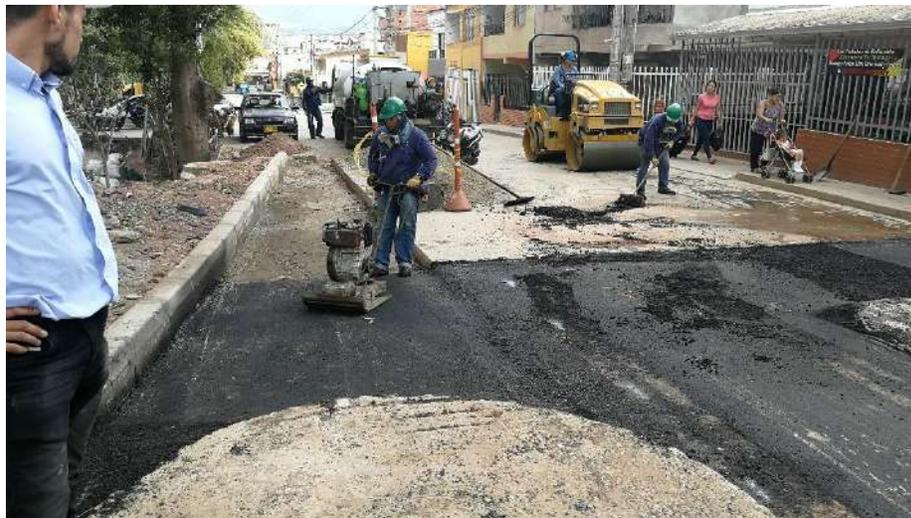
*Imagen 33. Compactación manual sobre mezcla asfáltica.*
