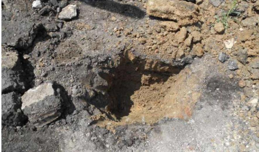
*Imagen 20. Apique de inspección de tuberías.*
