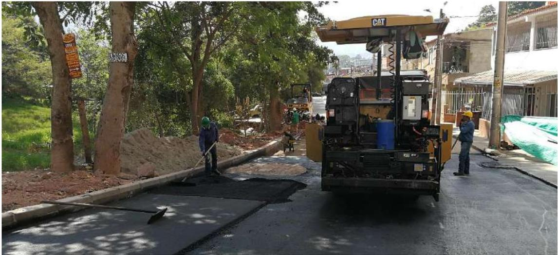
*Imagen 32. Extendido manual de mezcla asfáltica*
