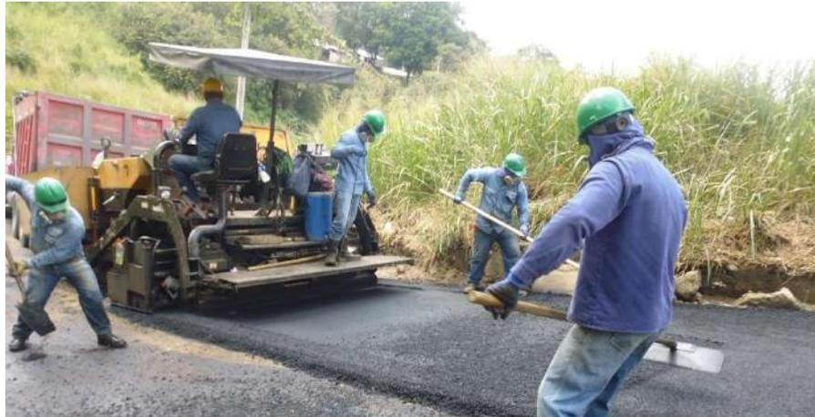
*Imagen 9. Instalación de mezcla asfáltica tipo MDC-19.*
