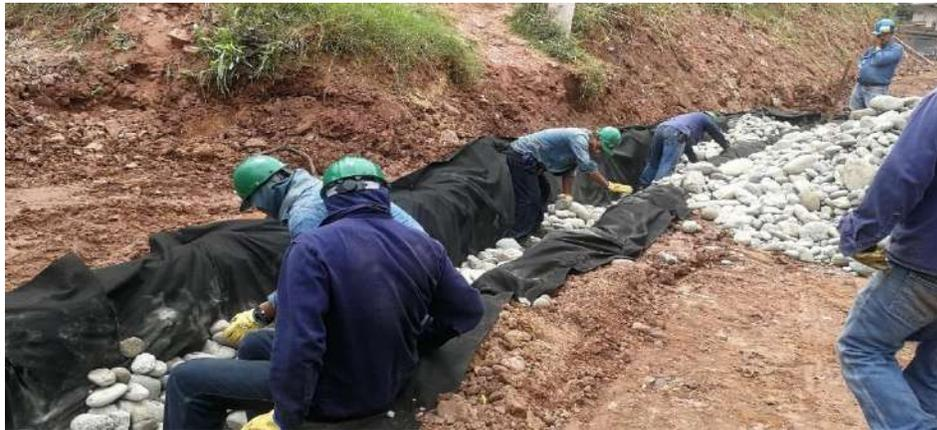
*Imagen 37. Geotextil no tejido relleno de "bolo redondo".*
