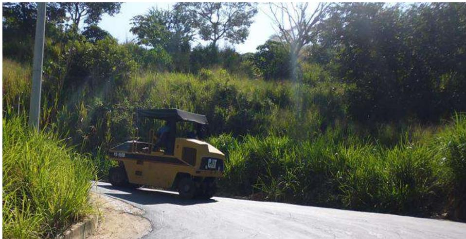
*Imagen 12. Compactación final de mezcla asfáltica.*
