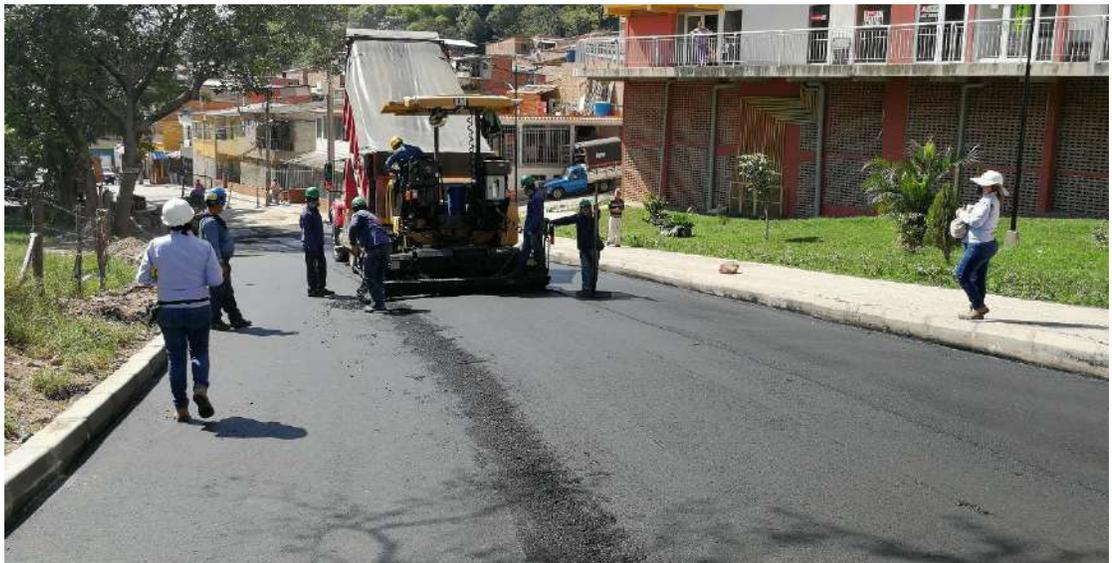
*Imagen 31. Instalación de segunda tira de mezcla asfáltica Zafiro.*
