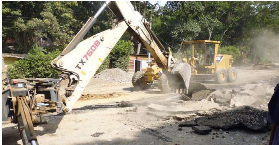
*Imagen 2. Demolición de pavimento existente.*
