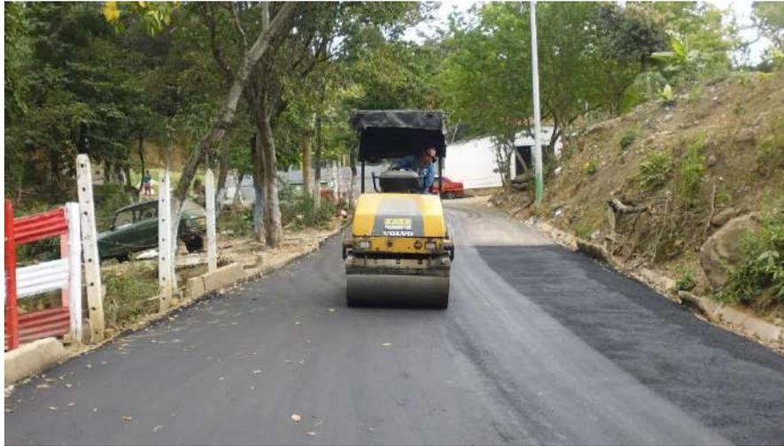
*Imagen 11. Compactación sobre junta longitudinal.*
