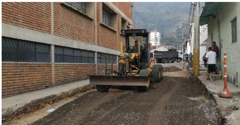
*Imagen 21. Instalación de base granular.*
