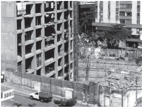
Fig. 5. Construcción de edificación dentro del área del parque de las mejoras públicas, Bucaramanga Foto: Revista el Crisol, 2014.
