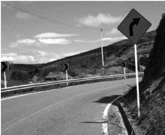
Fig. 5. Defensa metálica sin reparar y de escasa longitud.
