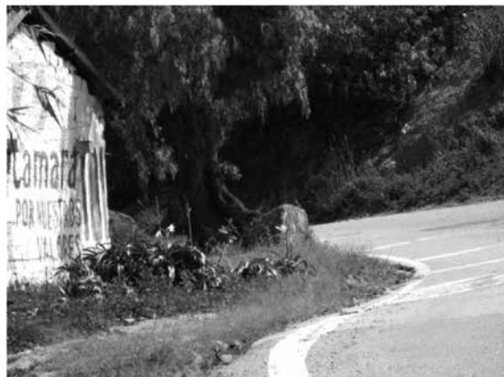
Fig. 4. Vivienda en curva a menos de 1.20 m del borde del pavimento.
