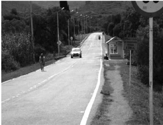
Fig. 1. Zona alledaña invadida por postes, puente angosto, peatones en la vía.
