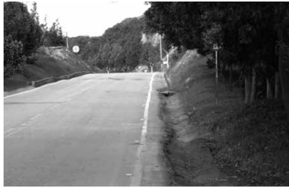
Fig. 7. Visibilidad de señal vertical obstruida por la vegetación.
