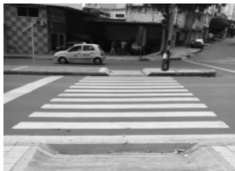
Fig 11. Cruce a nivel en la Avenida Quebrada Seca con carrera 32ª.
