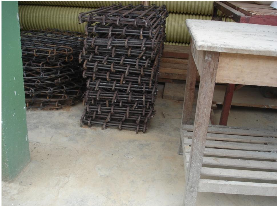
Ilustración 21 Prefabricados refuerzo de las tapas de concreto de los sumideros
