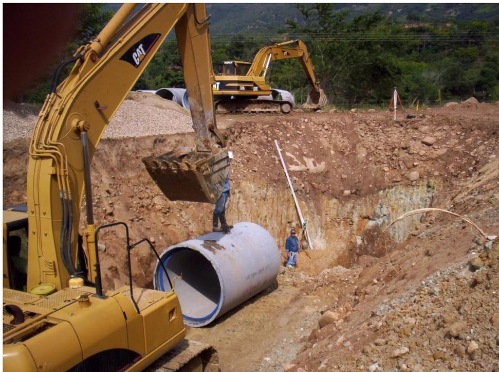
Ilustración 33 Interceptor Rio de Oro VI Etapa colocación de tubería de concreto de 1,40 m
