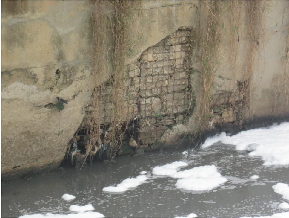
**Ilustración 16 Quebrada La Iglesia fractura de la pared del canal**
