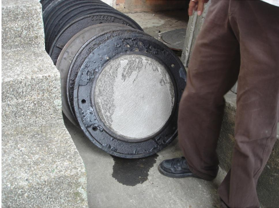
Ilustración 24 Prefabricados tapa de pozo o sumidero con núcleo de concreto
