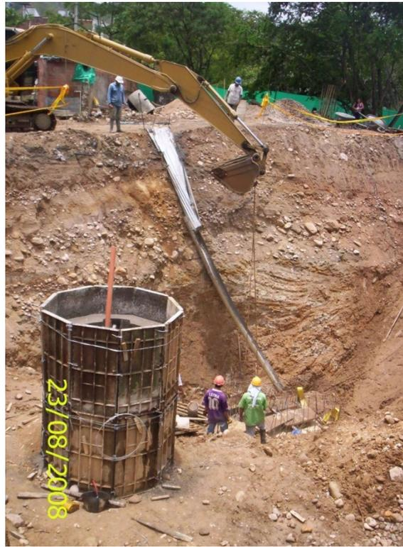
Ilustración 32 Interceptor Rio de Oro VI Etapa pozo de inspección y corte del talud
