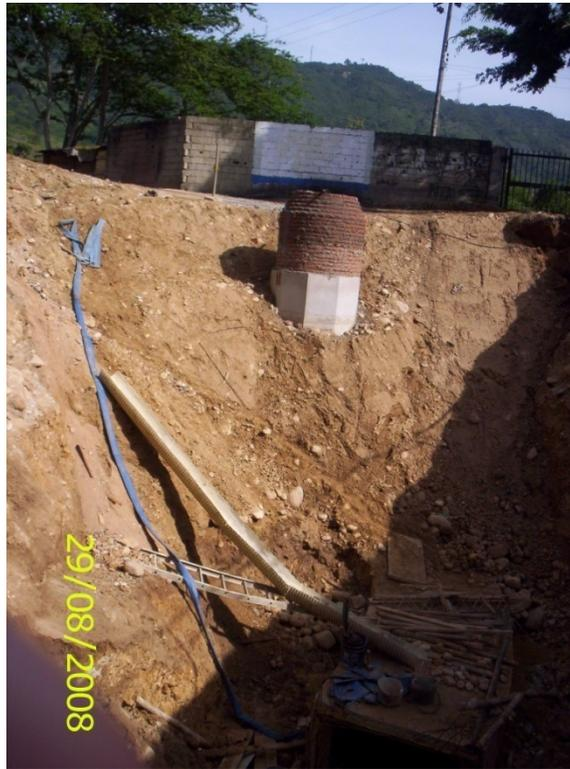
Ilustración 34 Interceptor Rio de Oro VI Etapa pozo de inspección terminado y curva horizontal terminada
