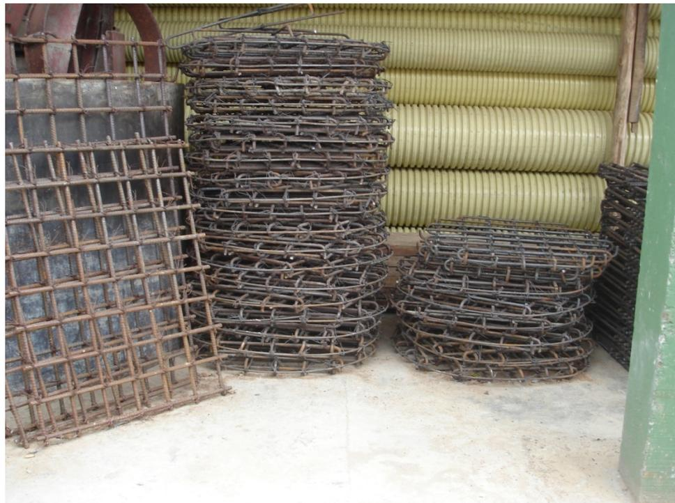
Ilustración 25 Prefabricados refuerzo de tapa de pozo en concreto refuerzo de placa de sumideros
