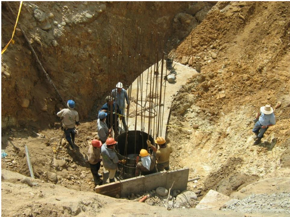
Ilustración 35 Interceptor Rio de Oro VI Etapa refuerzo pozo y curva horizontal terminada
