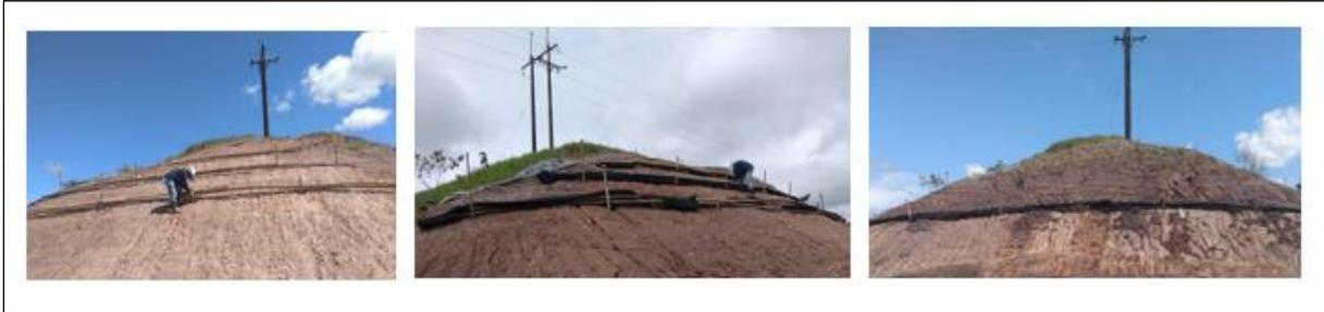
**Figura 13.** Proceso de recuperación de talud
