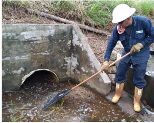
**Figura 7.** Mantenimiento de alcantarilla
