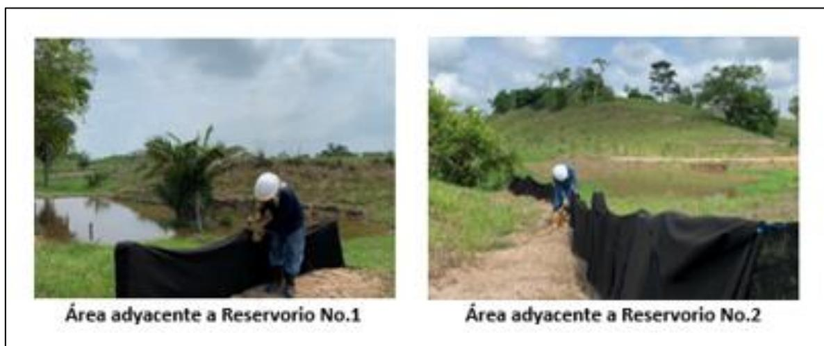
**Figura 10.** Mantenimiento a pantallas sedimentadoras
