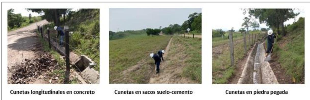
**Figura 8.** Mantenimiento a cunetas
