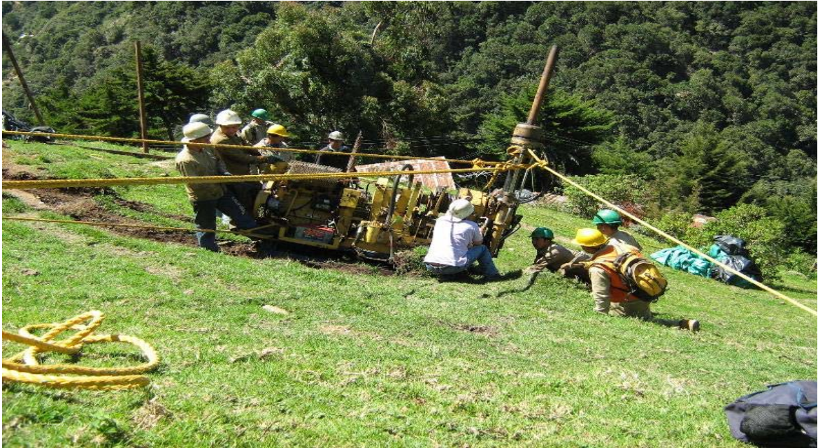
Figura 3. Traslado de la máquina de perforación hacia la plataforma
