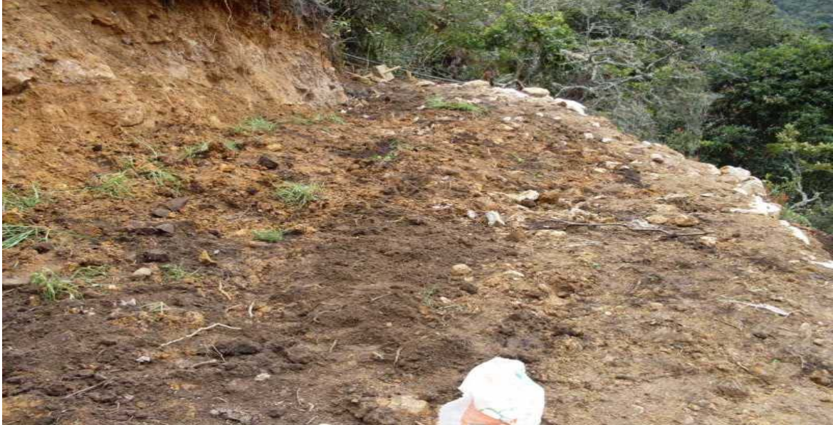
Figura 5. Recuperación de la plataforma de perforación
