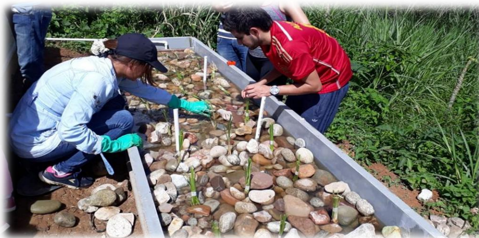
Figura 6. Implantación del vetiver en el sistema.
