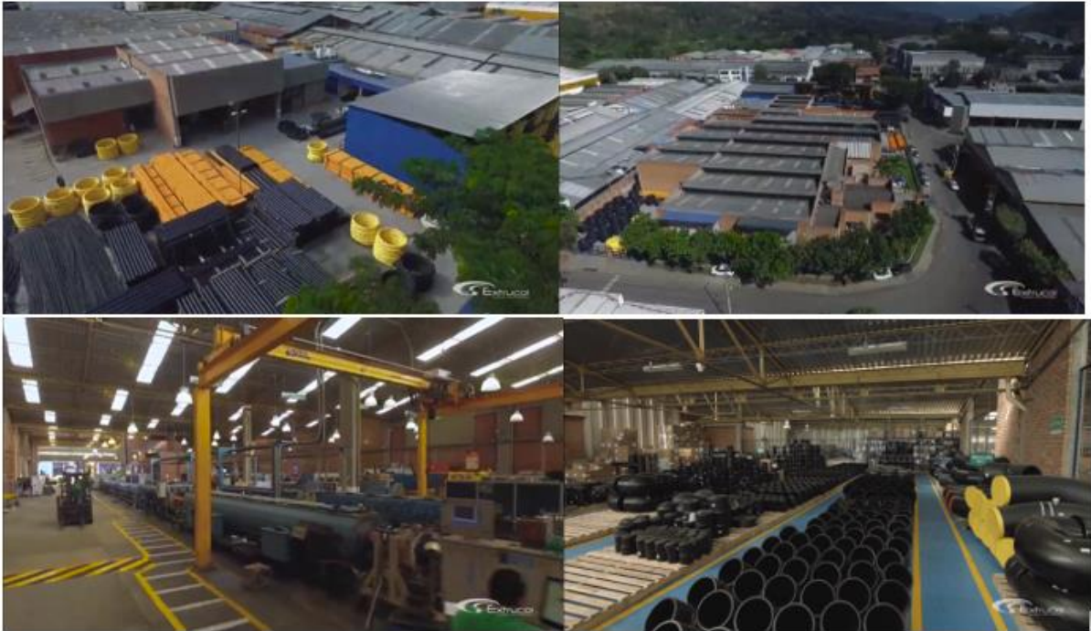
Ilustración 4. Instalaciones Extrucol S.A
