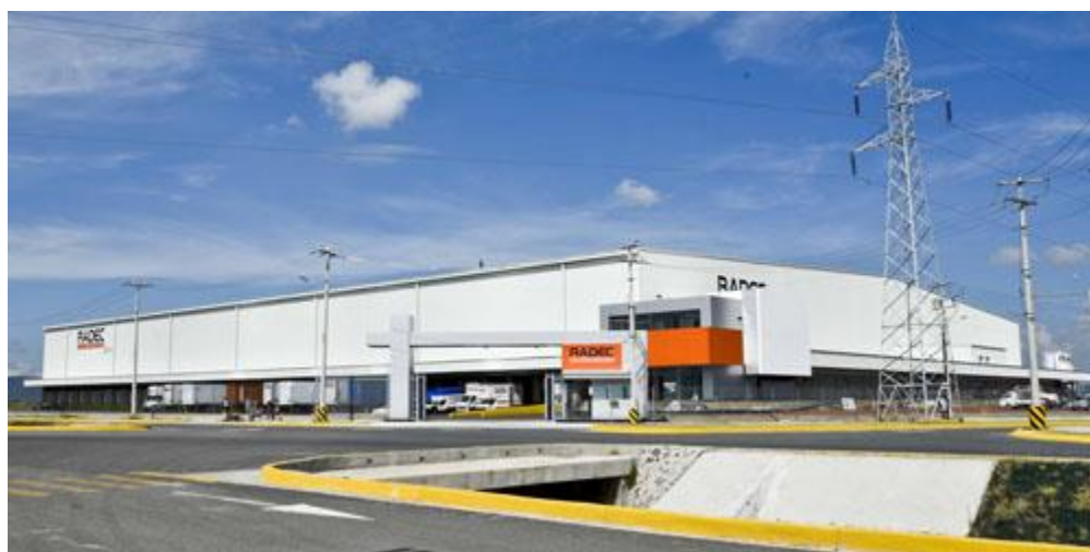
figura 4 Centro de distribución CLJ Guadalajara
