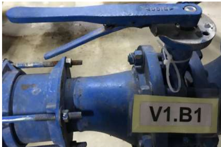
Gráfica 15. Cuarto de Bombas después. Parte 2.
