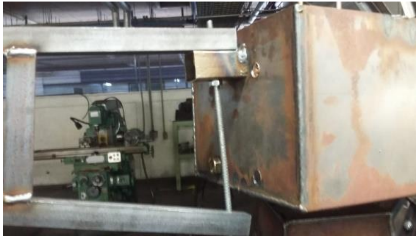
Figura 54. Instalación de veleta de orientación.
