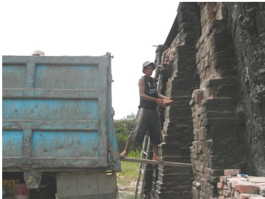
Fotografía 15. Extracción del Ladrillo del Horno a la Volqueta
