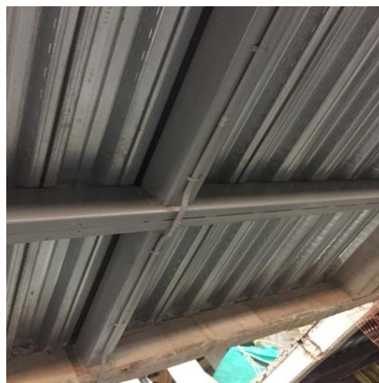
Figura 13. Unión de perlin y riostra sin aplicación Figura 14. Unión de perlin y riostra con aplicación.
