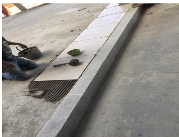
Figura 26. Baldosa colocada y nivelada.
