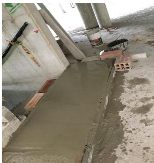
Figura 4. Andén fundido y nivelado.
