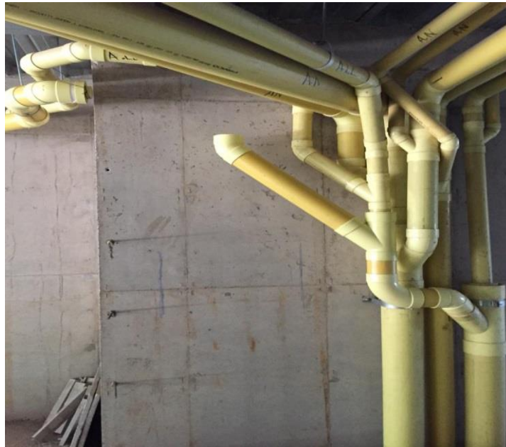
Figura 9. Red de sifón taponada a la espera de terminación de prueba para conectar a la bajante.
