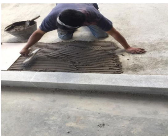
Figura 25. Aplicación de pegante.
