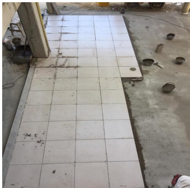
Figura 28. Instalación de enchape en portería y lobby.
