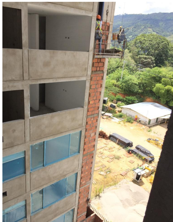
Figura 20. Avance de construcción
