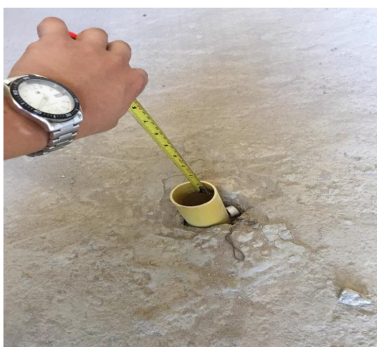
Figura 7. Medición para prueba de estanqueidad.
