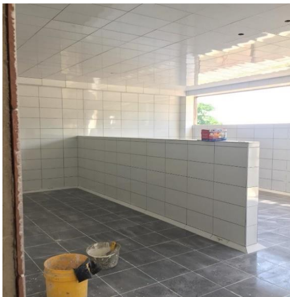
Figura 27. Cuarto de basura enchapado y en proceso de brechado.
