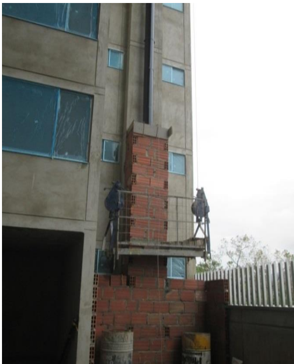
Figura 19. Inicio de construcción buitrón.
