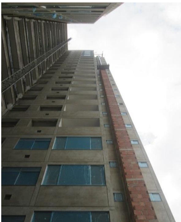
Figura 21. Avance de construcción buitrón.
