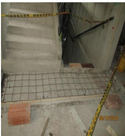
Figura 3. Armado de formaleta para fundida.
