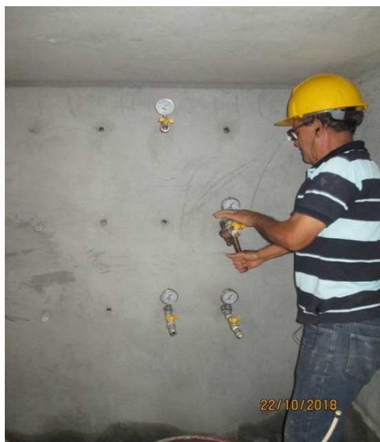
Figura 24. Instalación de manómetros.
