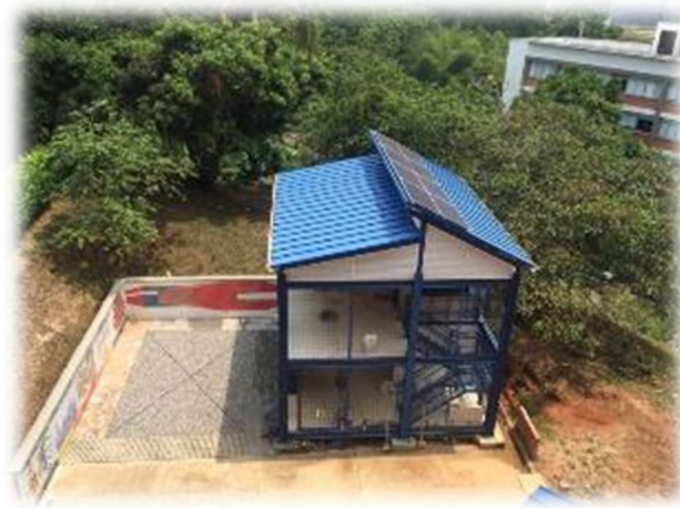
Figura 2. Figura laboratorio construcciones UPB
