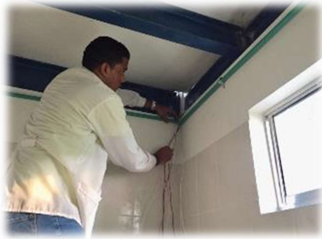
Figura 41. Instalación del cableado y tubería de PVC
