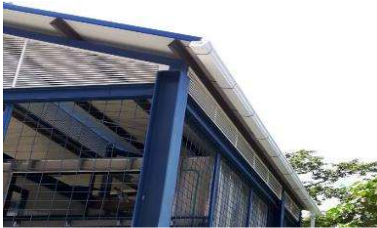
Figura 5. Canal borde lateral derecho.
