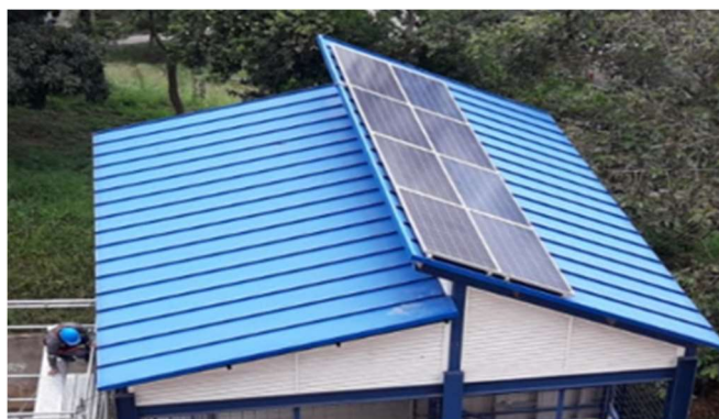
Figura 3. Cubierta laboratorio de construcción UPB
