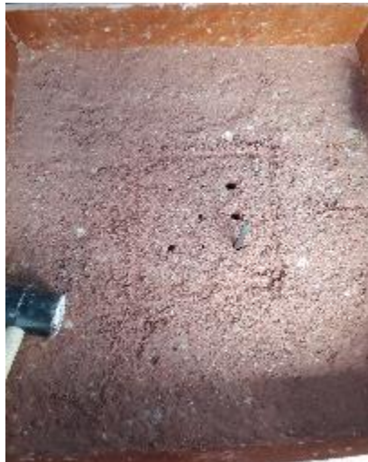
Fotografía 18. Delimitación de la placa y ubicación de los drenes.
