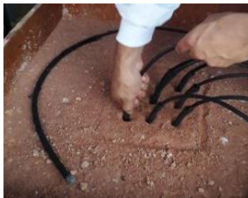
Fotografía 20. Implantación de los drenes.
