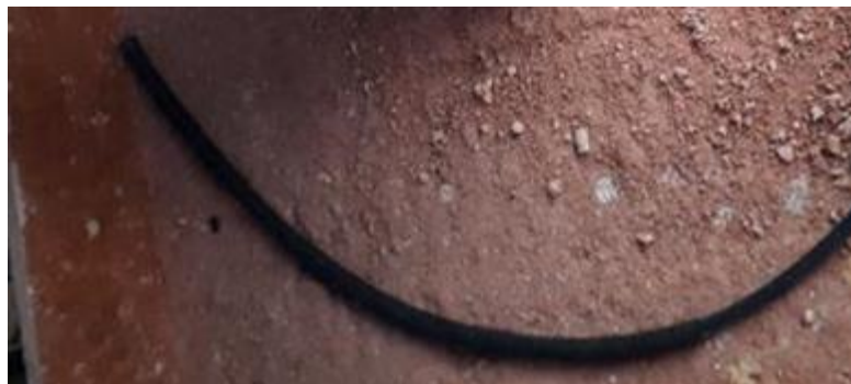
Fotografía 12. Dren cubierto con geotextil.
