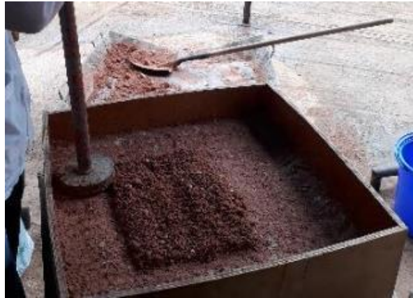
Fotografía 17. Compactación del estrato de arcilla.
