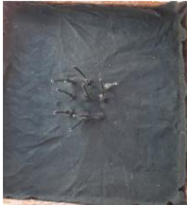
Fotografía 21. Separación con geotextil del estrato de arcilla y la grava.
