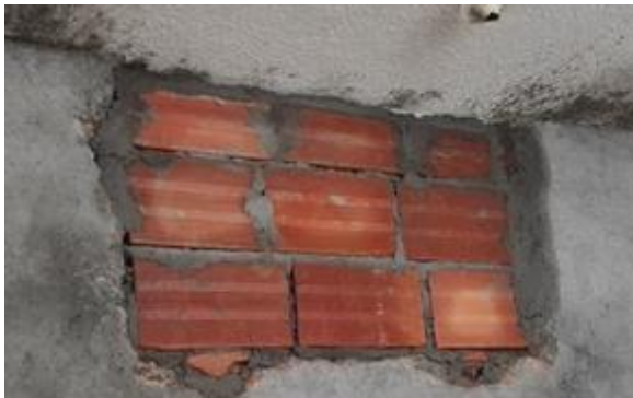
Ilustración 76 Desmonte y cerramiento de vano de ventana en mampostería.
