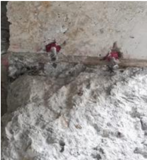
Ilustración 40 Incrustación del perno roscado en la parte superior de la Cara No 3 relleno de epoxico HILTI RE-500.
