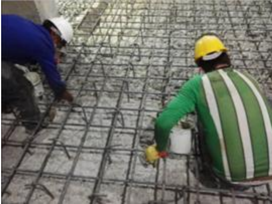
Ilustración 25 Aplicación del Epotoc L a las zapatas.
