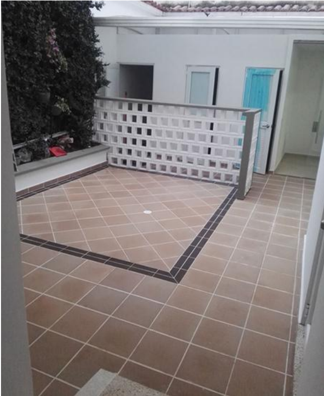
Ilustración 93 Estado final del patio y/o terraza.
