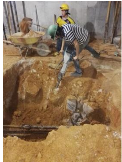
Ilustración 11 Demolición, excavación y retrancamiento entre la Z8 y la Z11.
