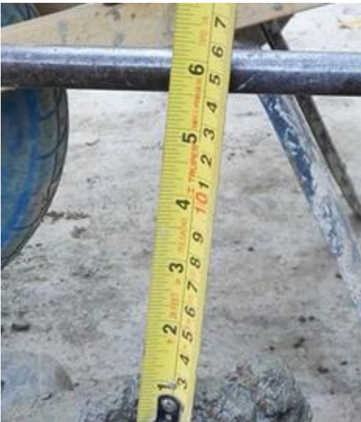
Ilustración 28 Asentamiento del concreto 3000 PSI para la tapa del tanque de almacenamiento.
