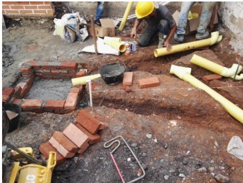
Ilustración 71 Ubicación de la caja primaria para los baños.
