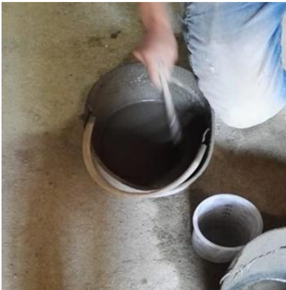
Ilustración 55 Preparación del Grouting para adicionarlo a la columna.
