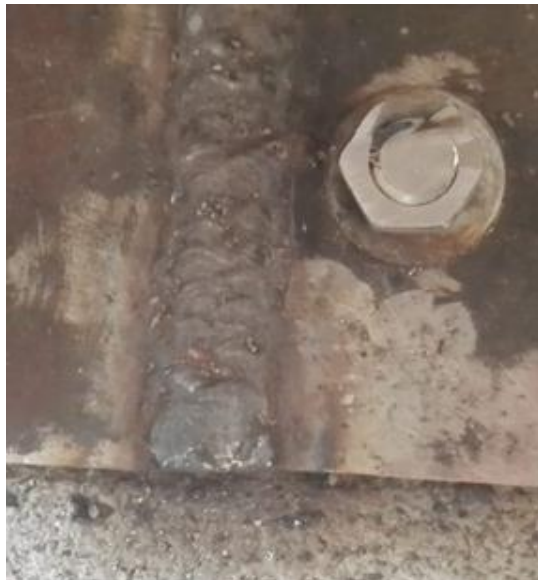
Ilustración 44 Aplicación de la soldadura 6010 en la platina inferior.
