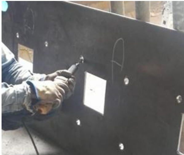
Ilustración 48 Biselado de las láminas para las perforaciones de los pernos.
