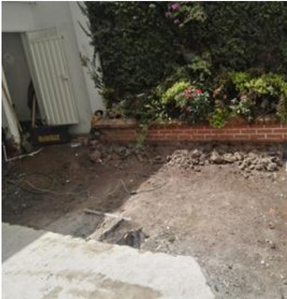
Ilustración 69 Descapote de zonas verdes y demolición del antepiso.
