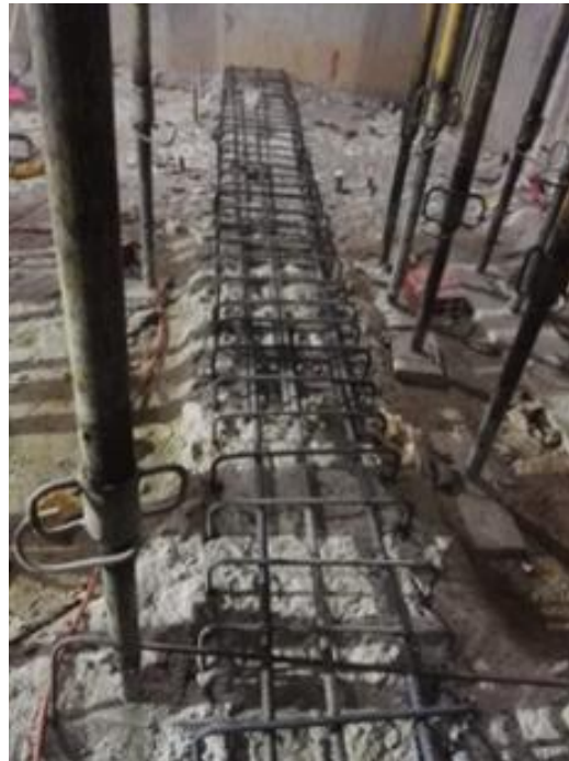
Ilustración 17 Anclajes en forma de U de 1/2" en la viga y amarradas a las varillas de 7/8" de los muros.
