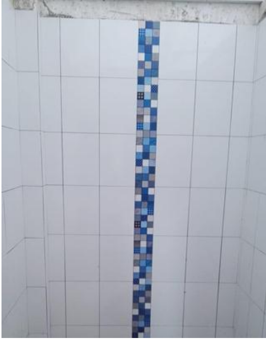
Ilustración 85 Enchape de los muros de los baños
