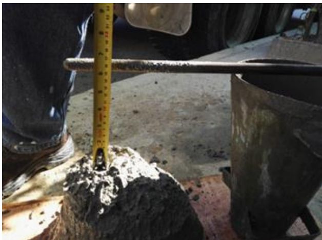
Ilustración 7 Prueba de asentamiento para el concreto del cuarto de máquinas.
