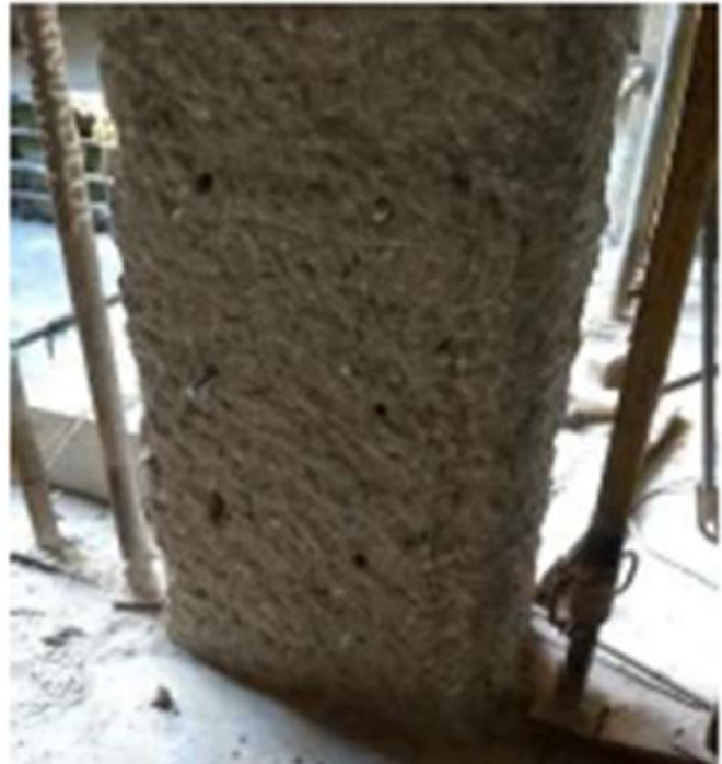
Ilustración 32 Perforaciones a la Cara No. 1
