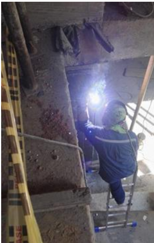
Ilustración 50 Aplicación de la soldadura 6010 en las aristas de la columna.
