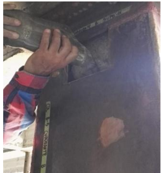
Ilustración 56 Vertimiento del Grouting adentro de la columna.
