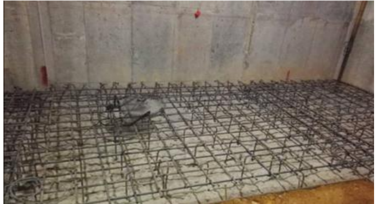
Ilustración 23 Conectores tipo "L" con las varillas de 1/2" ancladas a la Zapata.
