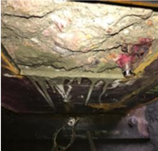
Ilustración 58 Grouting al interior de la columna.
