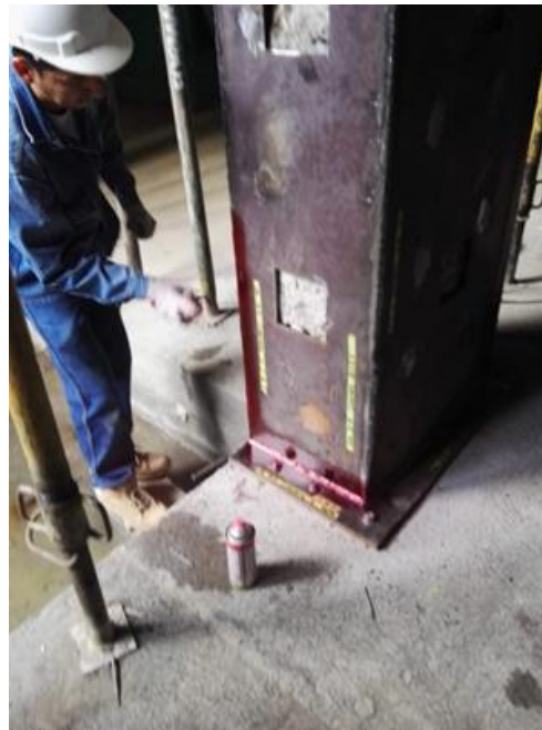
Ilustración 60 Aplicación del aerosol penetrante a la arista de la columna.
