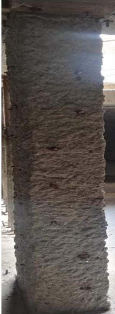
Ilustración 35 Incrustación de los pernos roscados en la Cara No 2 relleno de epoxico HILTI RE-500.
