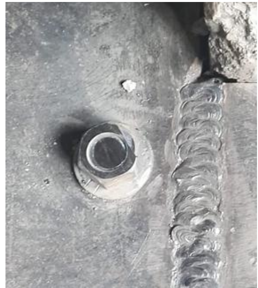
Ilustración 45 Aplicación de la soldadura electrodo manual revestida en la platina inferior.
