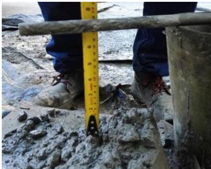
Ilustración 26 Asentamiento para uno de las mixer de la fundida de las zapatas.
