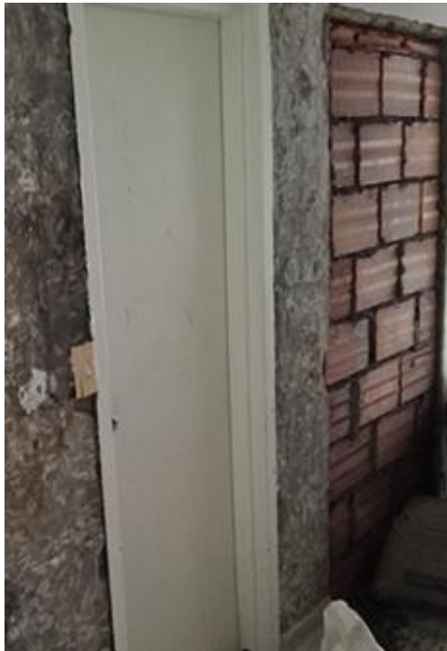
Ilustración 74 Mampostería de encerramiento muro del archivador.
