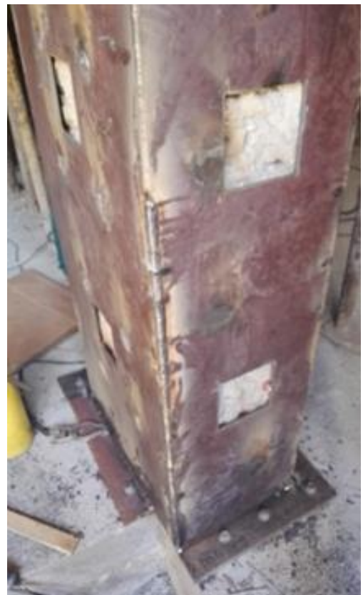
Ilustración 49 Resultado final de la soldadura 7018.
