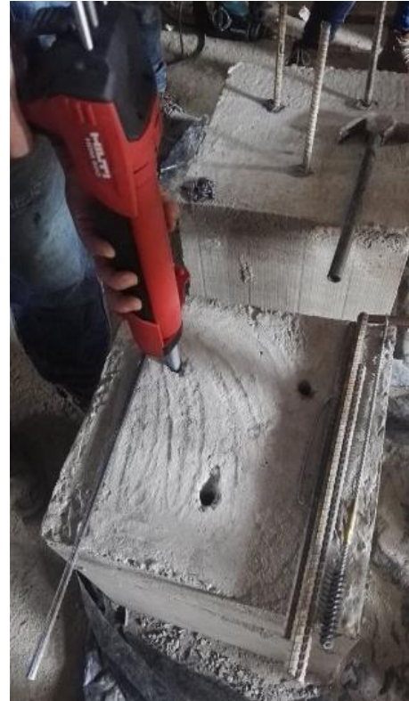
Ilustración 19 Anclajes con varillas de 1/2" en los dados de concreto.
