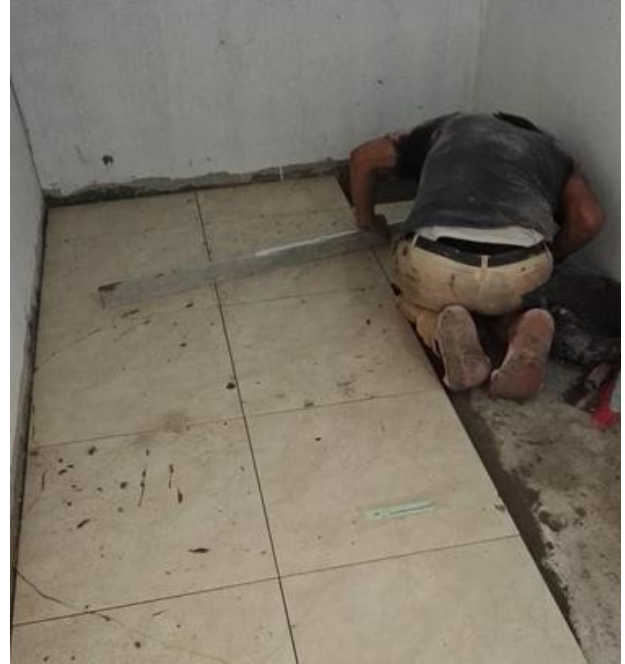
Ilustración 84 Enchape de pisos para zonas de cafetería, archivador y oficina de atención al usuario.
