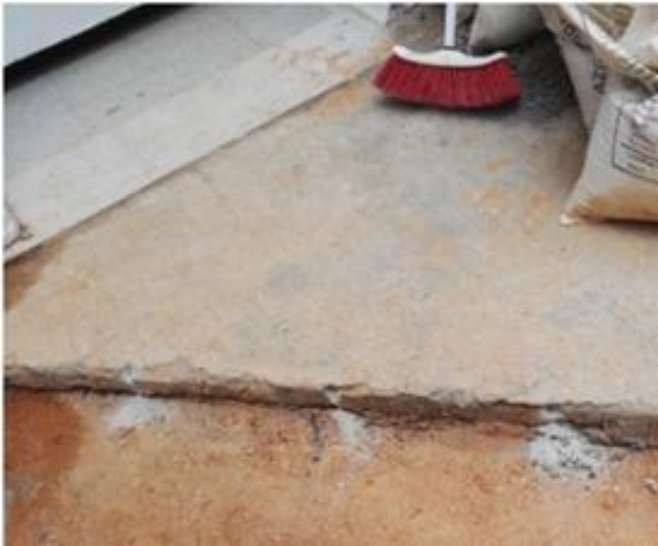
Ilustración 72 Perforaciones al antepiso existente para las dovelas.
