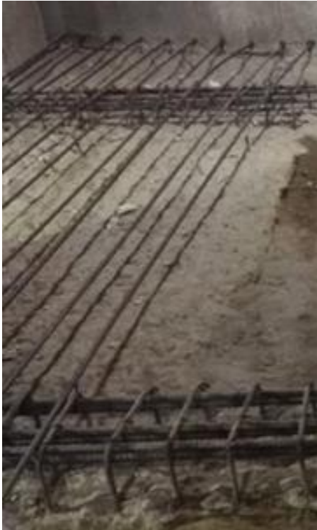
Ilustración 24 Armado de la malla, anclando a las pantallas con varillas de 5/8".
