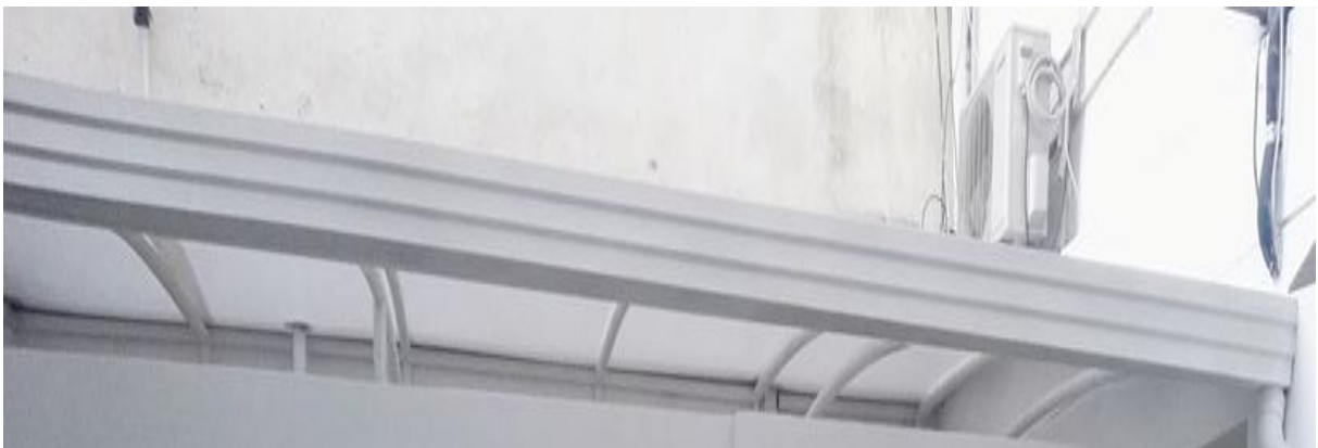
Ilustración 92 Domo para la el techo de los baños con su respectiva viga canal de aguas lluvias.
