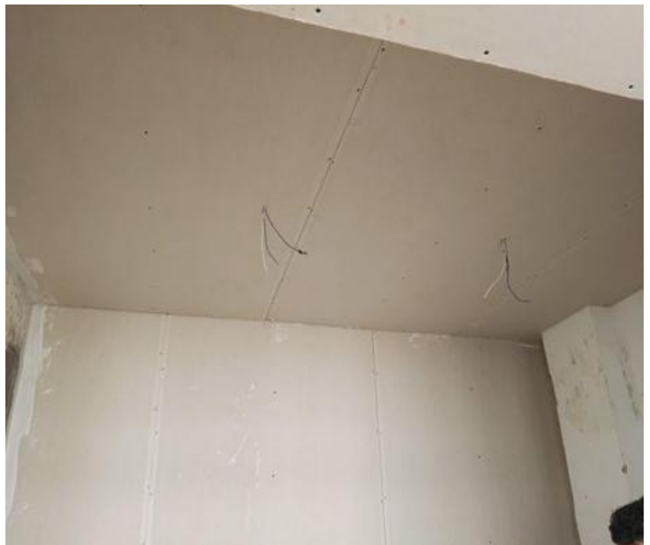
Ilustración 83 Cielo raso en el área de la cafetería
