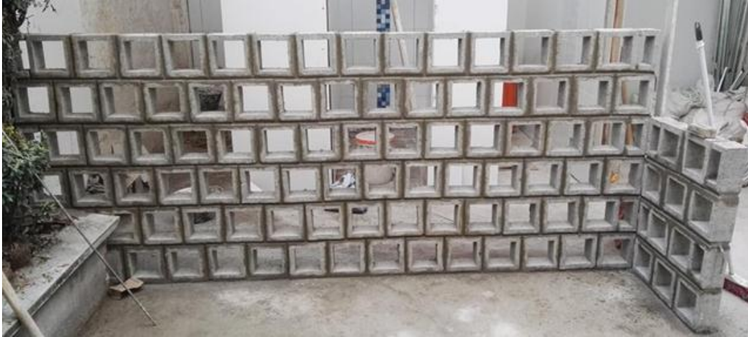
Ilustración 86 Muro de calados con los refuerzos.
