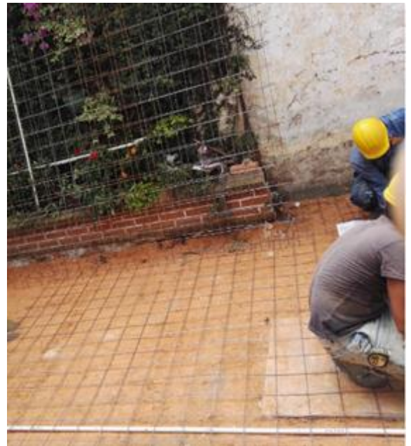
Ilustración 73 Replanteo de la capa de tierra compactada y amarre de la malla electrosoldada.
