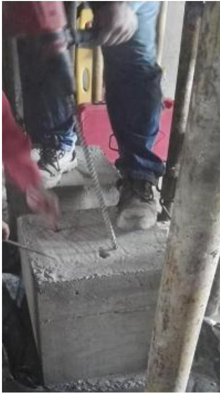
Ilustración 18 Perforaciones a los dados de concreto
