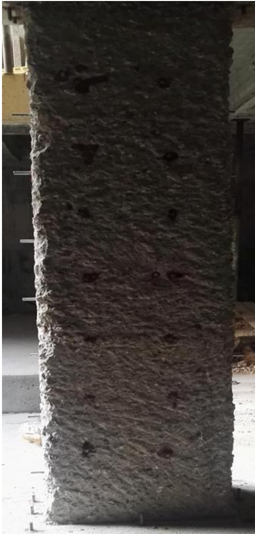
Ilustración 33 Incrustación de los pernos roscados en la Cara No 1 relleno de epoxico HILTI RE-500.
