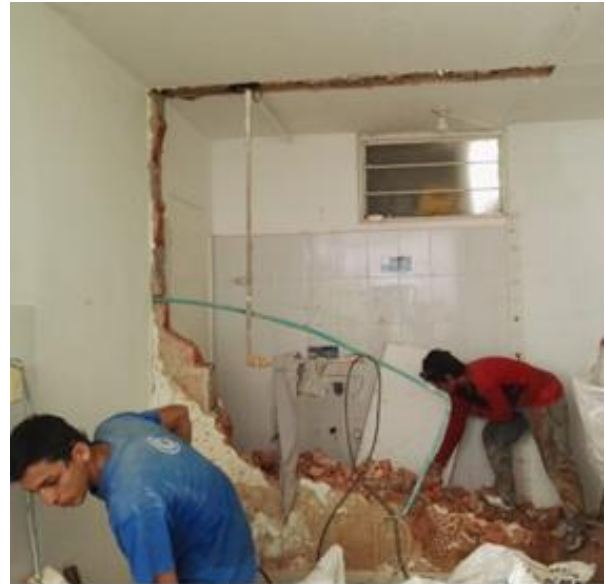
Ilustración 70 Demolición de la cocina y baño.
