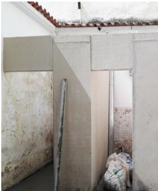
Ilustración 82 Muros y dinteles de baños en Eterboard.
