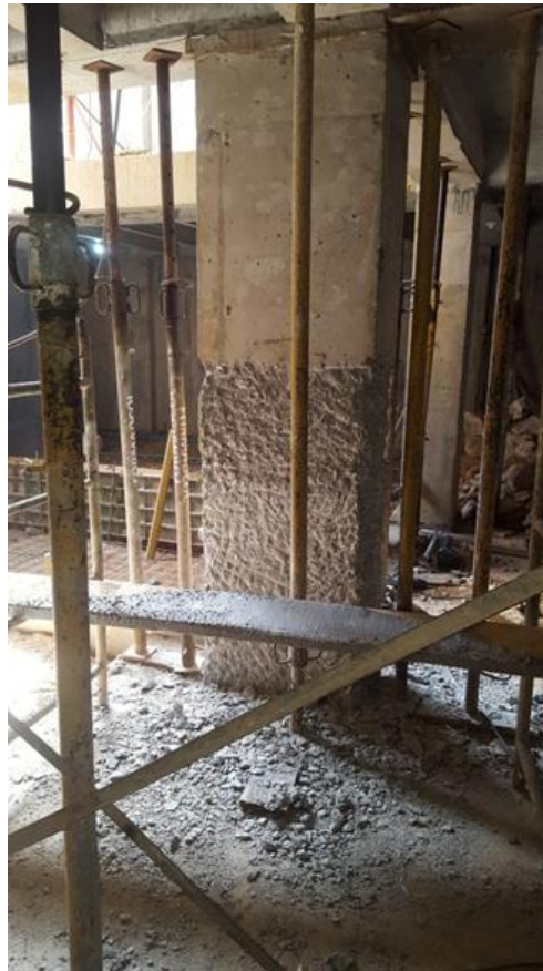
Ilustración 30 Escarificación de la columna B-5
