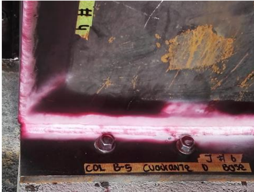
Ilustración 65 Cordón de soldadura bien aplicado en la platina inferior
