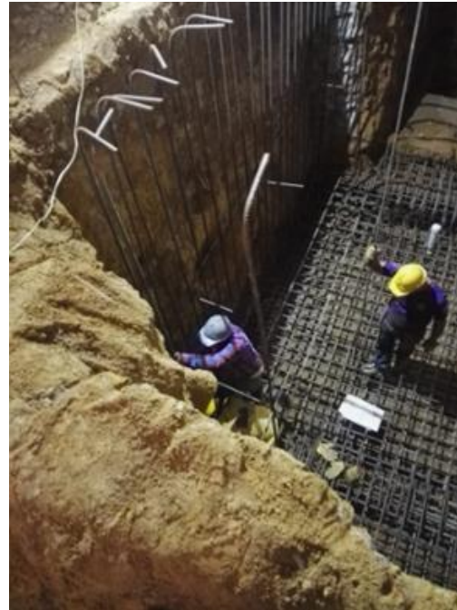
Ilustración 5 Ubicación de los empalmes en los muros del tanque.
