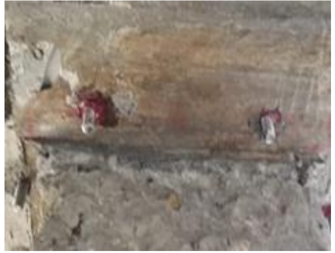
Ilustración 37 Incrustación del perno roscado en la parte superior de la Cara No 2 relleno de epoxico HILTI RE-500.
