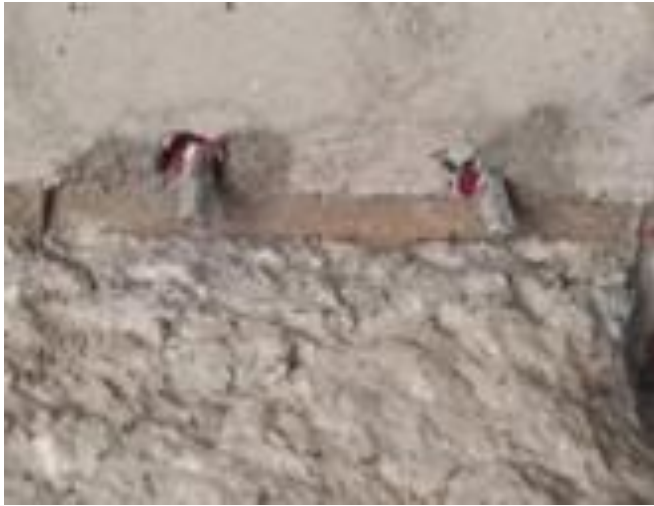
Ilustración 38 Incrustación del perno roscado en la parte superior de la Cara No 1 relleno de epoxico HILTI RE-500
