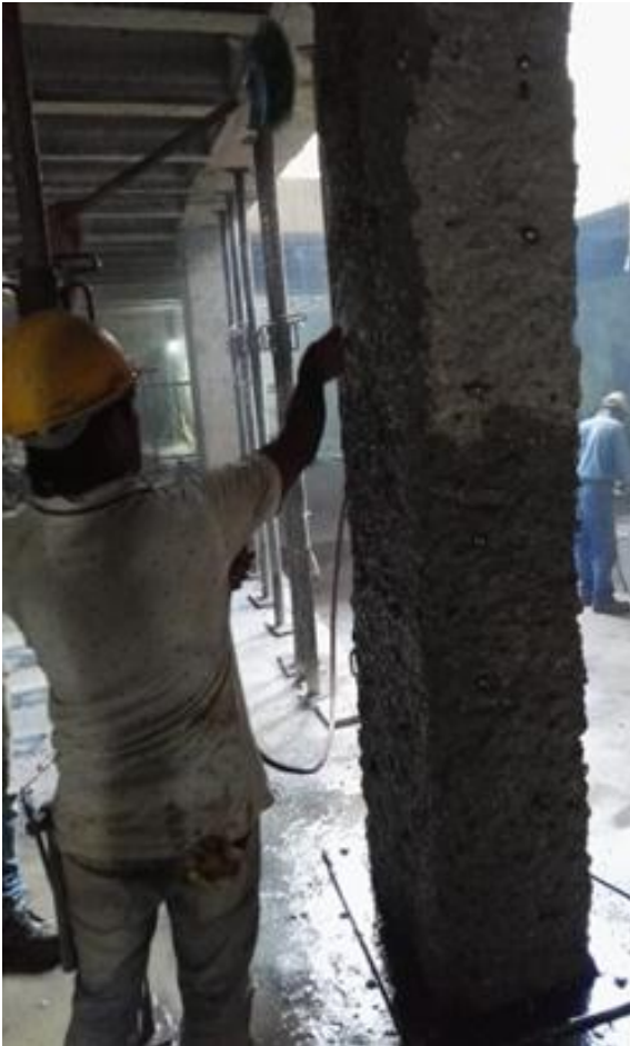
Ilustración 46 Lavado de la columna en la Cara No 1 y 2.
