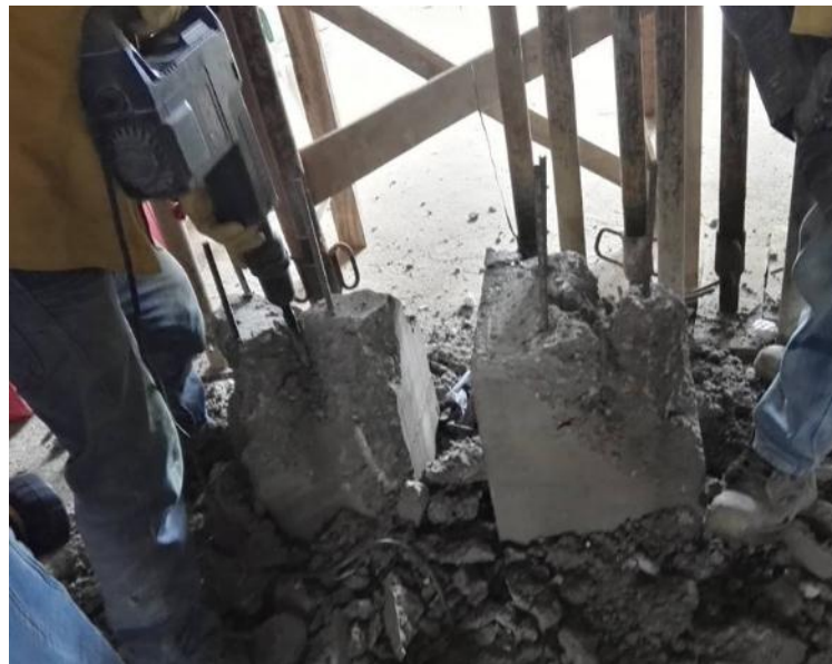
Ilustración 20 Demolición y resultados de los anclajes realizados.
