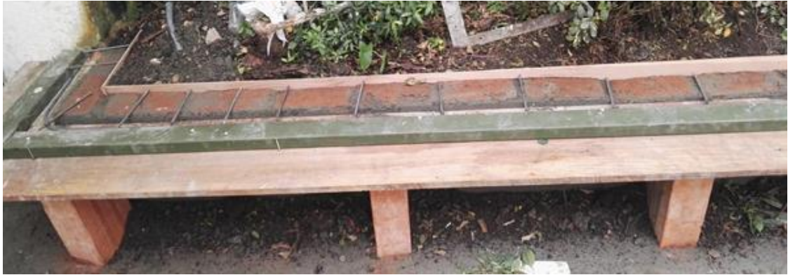
Ilustración 81 Acero de refuerzo para la alfajía en jardinera existente.
