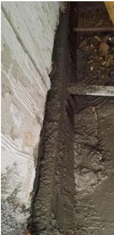
Ilustración 80 Fundida de la viga de amarre.
