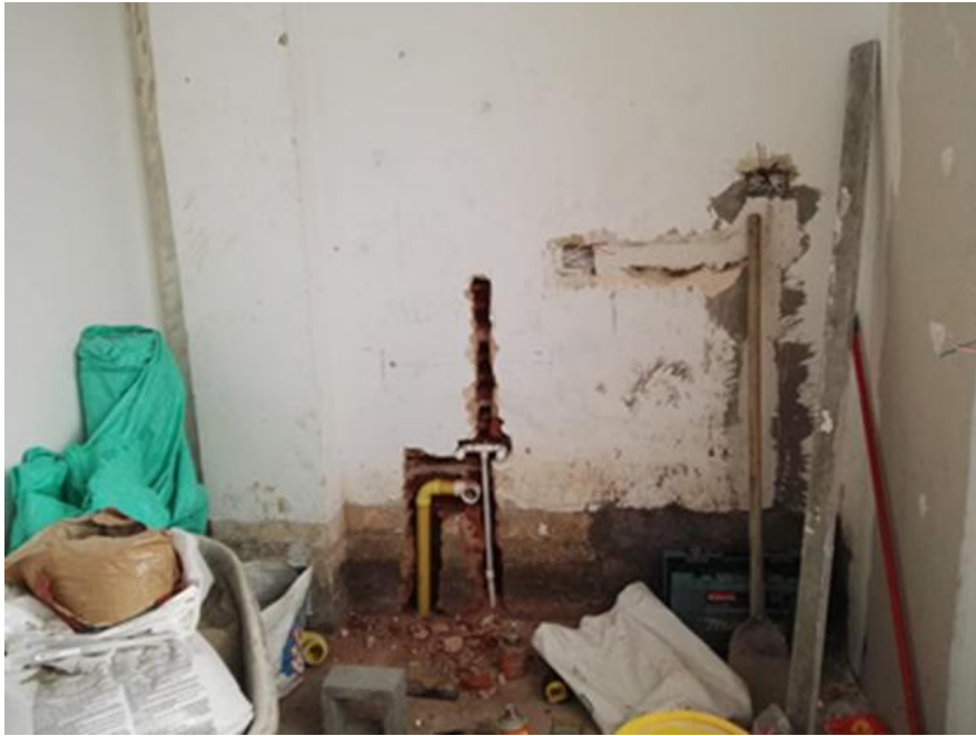
Ilustración 78 Regatas en muros para puntos eléctricos, sanitarios e hidráulicos.
