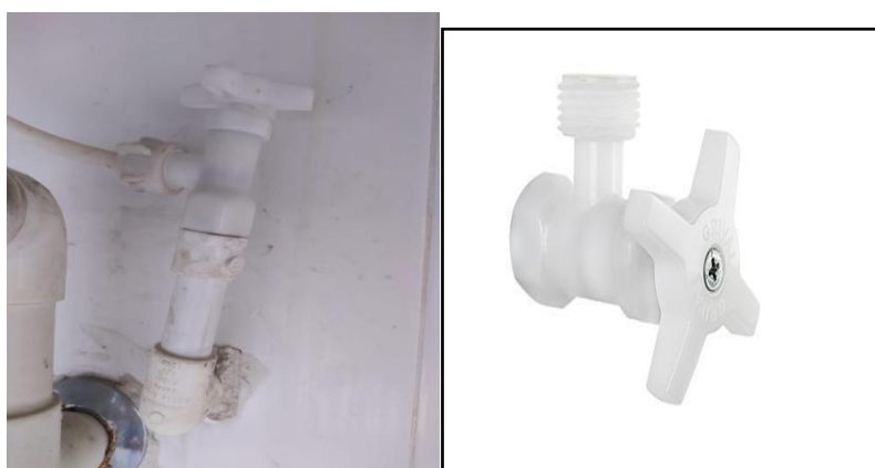
Ilustración 11. Instalación de válvulas reguladoras de agua
