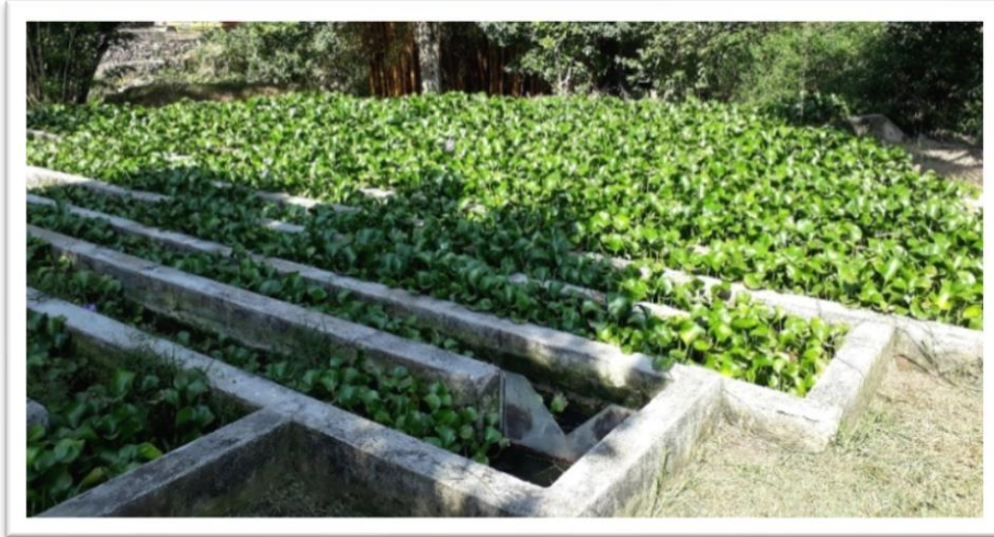
Figura 6. Tratamiento Secundario - terciario con Buchón de agua.
