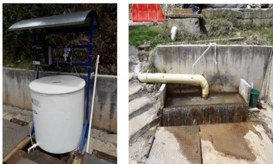
*Figura 6.* Estructuras de corrección de pH. Fuente: Autor.
