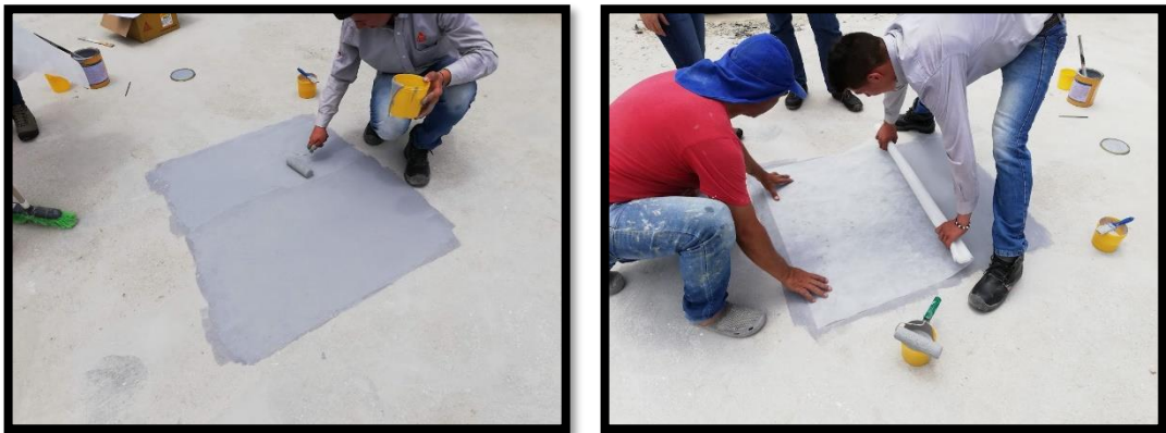
Figura 38 Aplicación de Sikafill 300 Thermic en Edificio Hacienda Mayor
