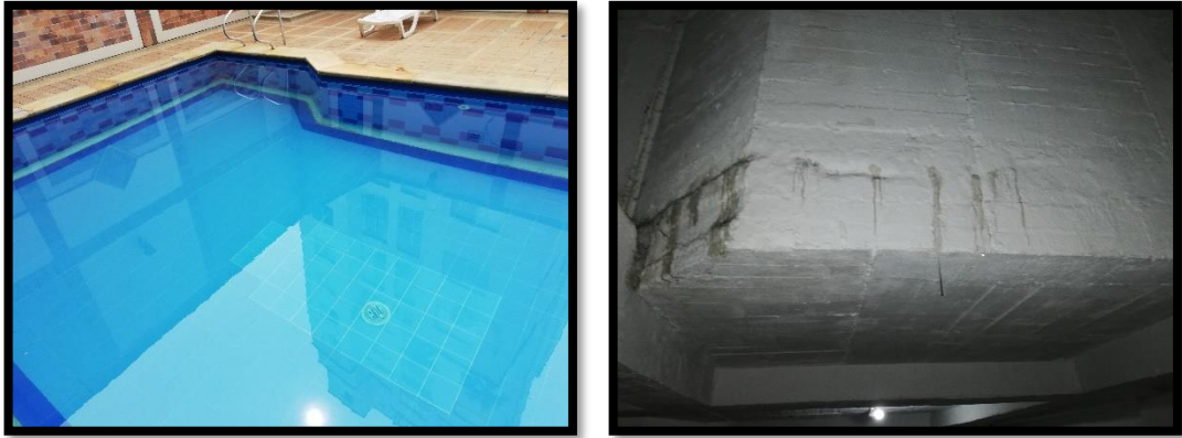
Figura 17 Filtración presente en junta fría en edificio Ayamonte
