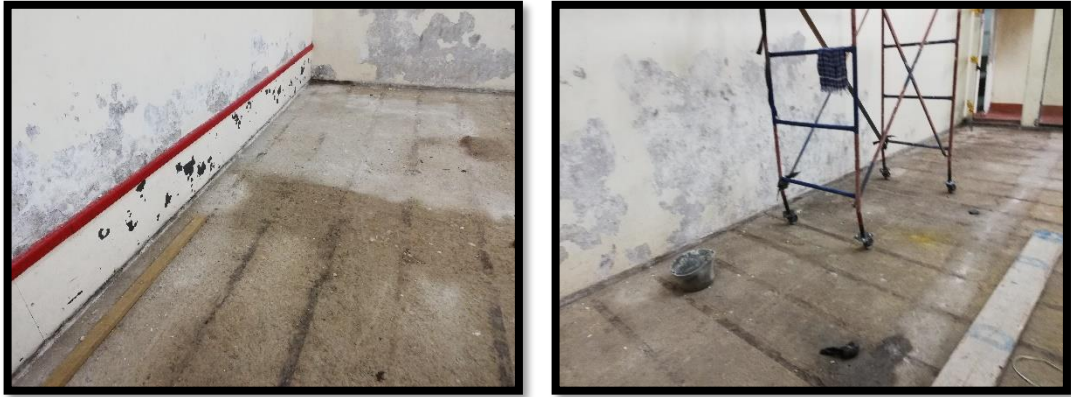
Figura 14 Humedad generada por nivel freático en conjunto Miradores de San Lorenzo
