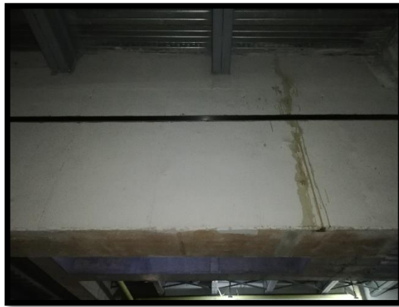
Figura 14 Humedad generada por nivel freático en conjunto Miradores de San Lorenzo
