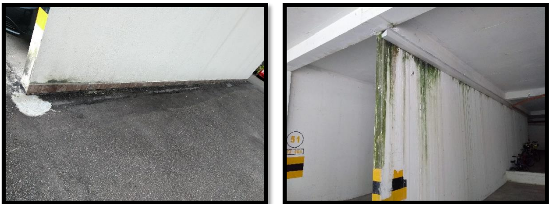
Figura 9 Filtración presente en plazoleta común en conjunto Alameda del Viento
