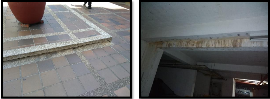
Figura 9 Filtración presente en plazoleta común en conjunto Alameda del Viento
