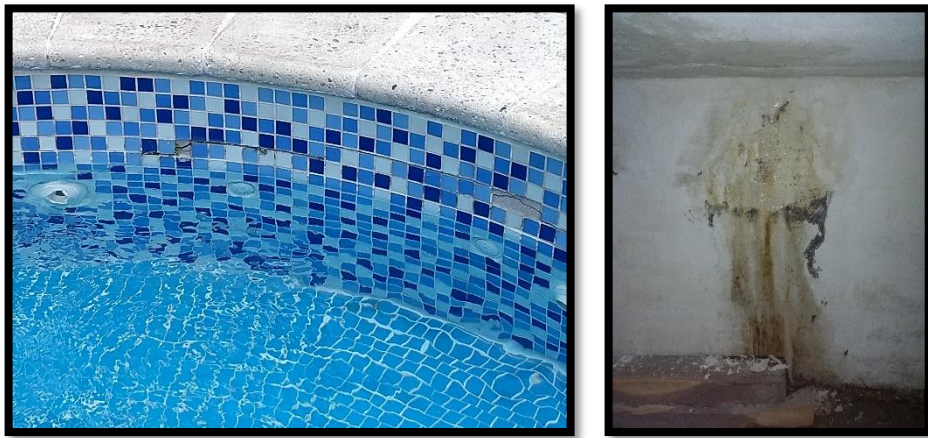
Figura 17 Filtración presente en junta fría en edificio Ayamonte
