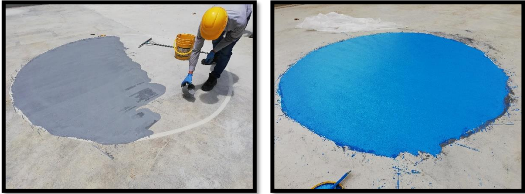
Figura 37 Aplicación de sistema para canchas Sika Sport Line en Edificio Aqua
