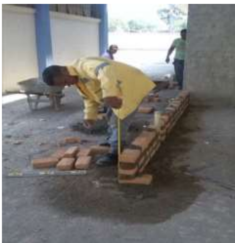
Imagen 11. Verificando la nivelación.
