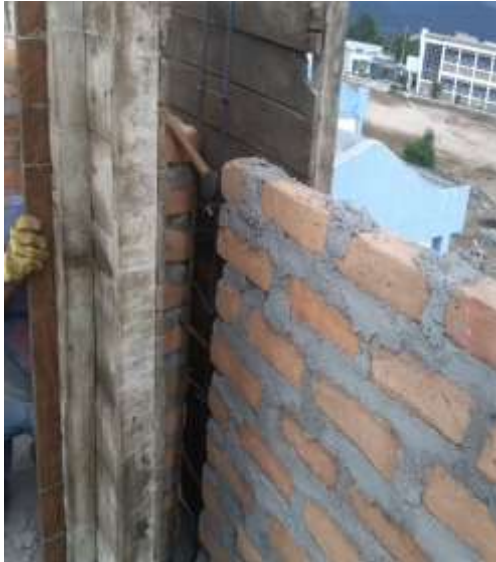
Imagen 1. Instalación de formaletas para Columnetas.
