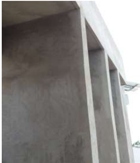
Imagen 19. Pañete externo en muros laterales.
