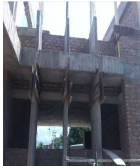
Imagen 4. Vaciado de concreto para pantallas.
