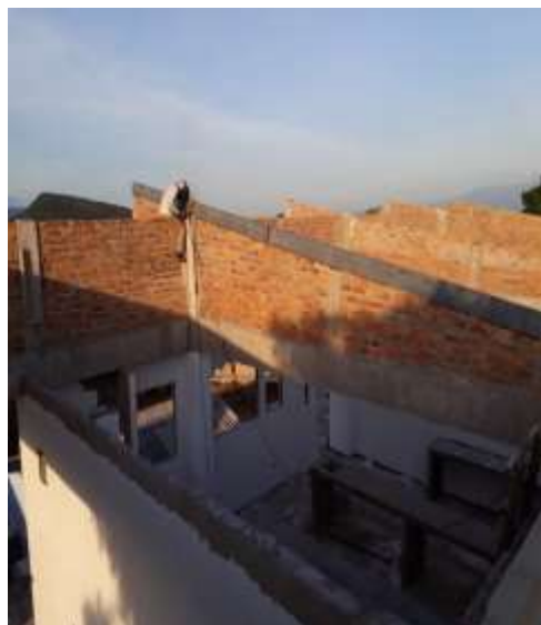
Imagen 30. Instalación de platinas sobre cuchillas.
