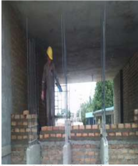
Imagen 35. Visita de inspección.
