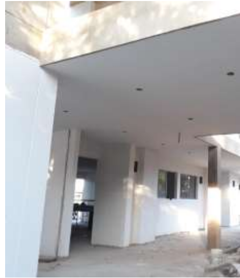
Imagen 28. Aplicación de estuco bajo placa
