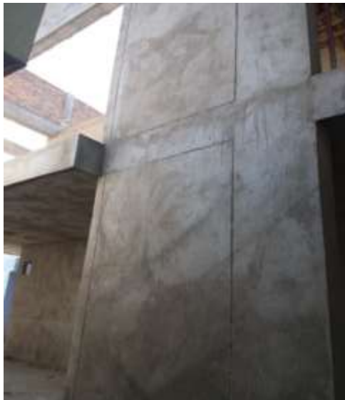
Imagen 18. Pañete en muros externos-frontales.
