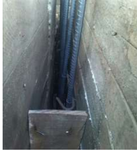
Imagen 10. Instalación del acero de refuerzo.
