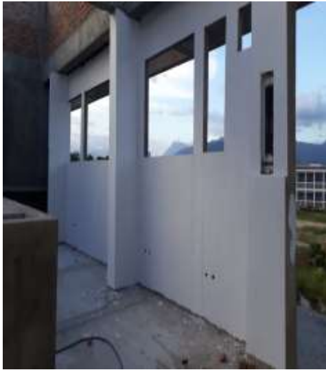
Imagen 27. Aplicación de estuco en muros internos.
