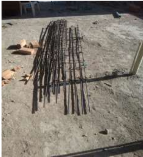
Imagen 9. Figuración del acero de refuerzo.
