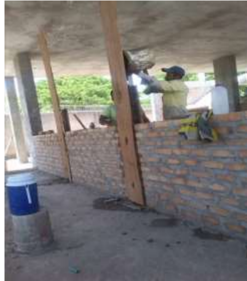
Imagen 2. Vaciado de mezcla para columnetas.
