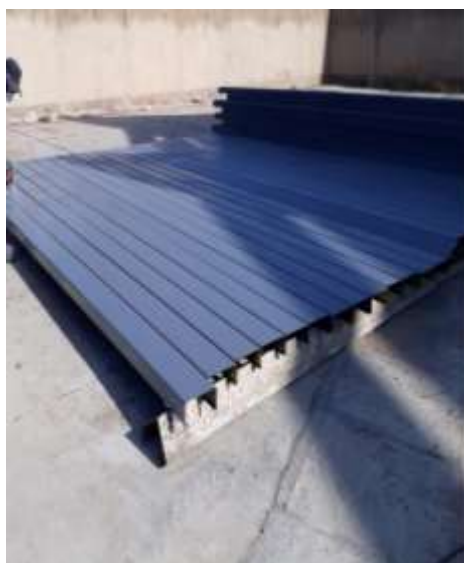
Imagen 29. Aplicación de pintura anticorrosiva en las platinas.
