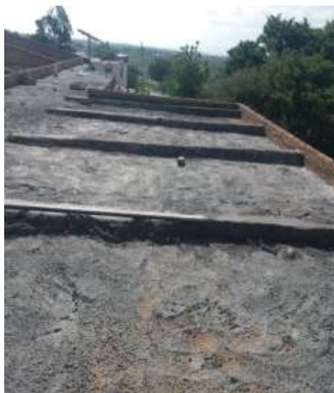
Imagen 31. Toma de puntos de referencia para la inclinación de la torta de desnivel.
