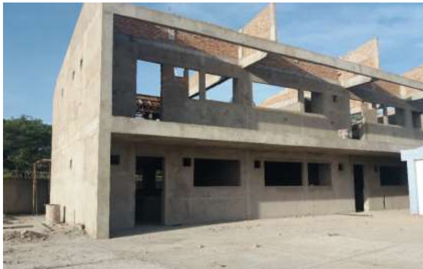
Imagen 26. Vista lateral de la estructura finalizado la actividad de pañete.
