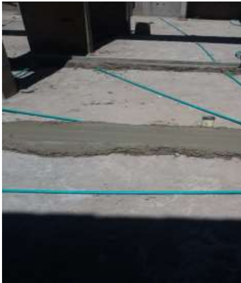
Imagen 24. Puntos guías para la nivelación antes de echar plantilla
