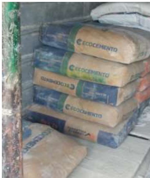
Imagen 33. Almacenamiento del material en bodega sobre tableros.
