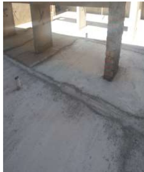
Imagen 25. Plantilla de nivelación en piso terminada.
