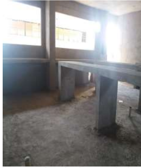
Imagen 36. Jornadas de aseo en la obra.
