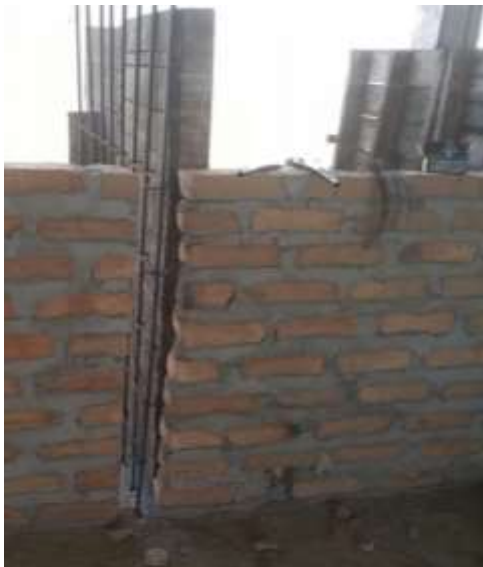
Imagen 3. Instalación del acero de refuerzo y formaleteria para pantallas.
