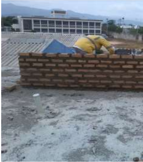
Imagen 13. Levante de muro en mampostería segundo piso.
