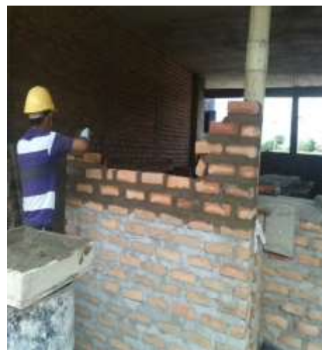
Imagen 12. Levante de muro en mampostería primer piso.
