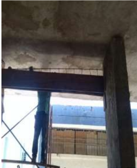
Imagen 5. Instalación del acero de refuerzo para dinteles.
