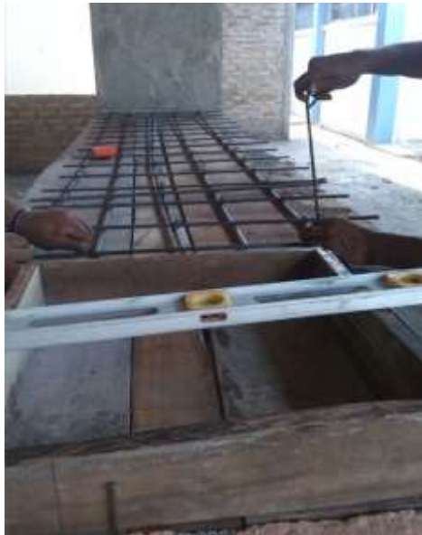
Imagen 7. Instalación del acero de refuerzo para mesones.
