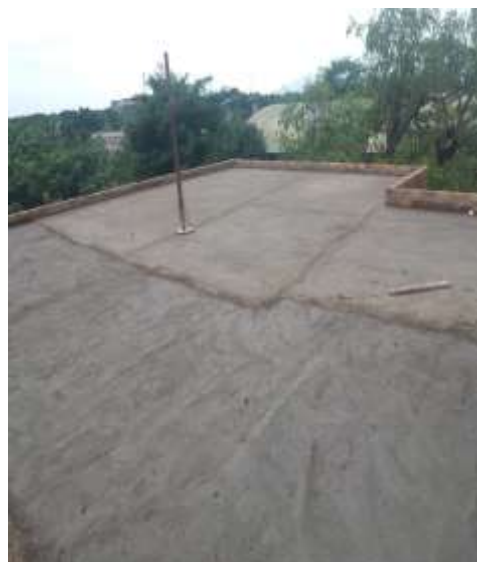
Imagen 32. Aplicación de mezcla de concreto pobre encima del relleno compactado.
