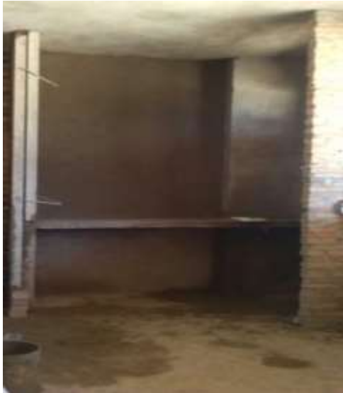
Imagen 16. Inicio de pañete en muros interno.
