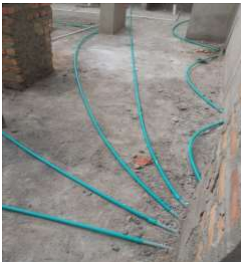
Imagen 22. Instalación de la tubería eléctrica de los laboratorios segunda planta.
