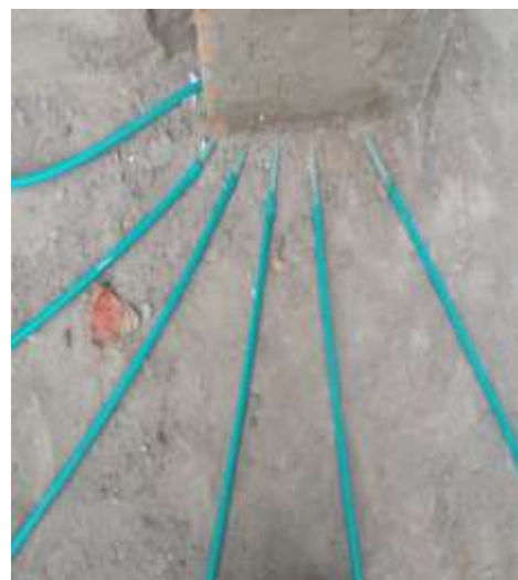
Imagen 23. Salida de tubería eléctrica de la caja eléctrica a puntos eléctricos.
