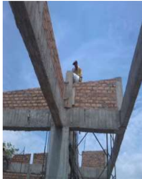
Imagen 15. Construcción de cuchilla para cubierta.
