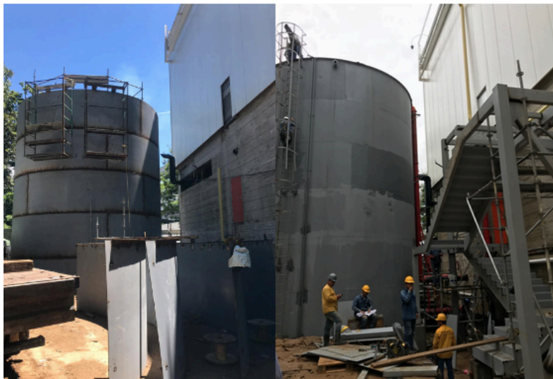
Figura 24. Tanque de Almacenamiento de 500 m 3 . (Autor, 2018)
