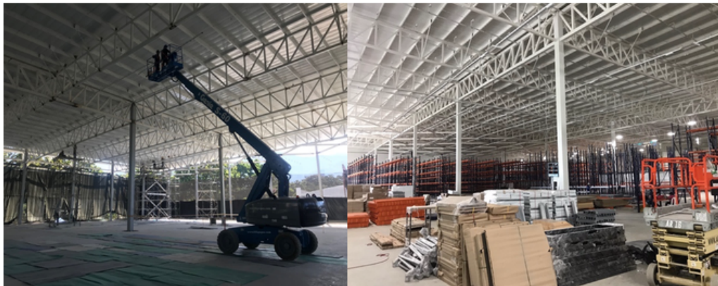
Figura 30. Área almacén antes y después. (Autor, 2018)
