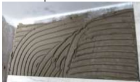
Figura 53. Ejemplo de aplicación de pego constructor cerámico en muro de baño del apartamento 1504.
