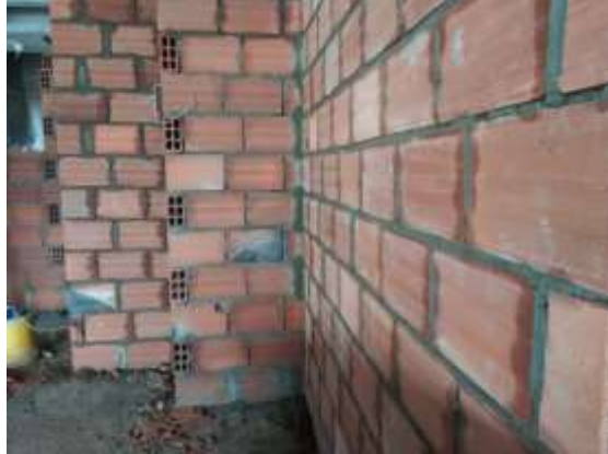
Figura 5. Mampostería no estructural, método de panderete.
