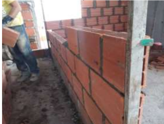
Figura 6. Nivelación de mampostería por medio de hiladas.
