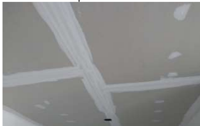
Figura 29. Fase de encintada y empaste de juntas, camuflaje de tornillos en cielo raso del apartamento 1302.
