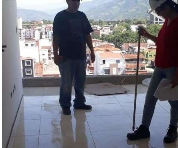
Figura 49. Revisión de cocos apartamento 902
