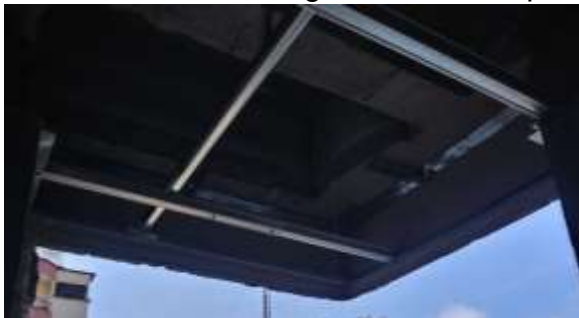
Figura 27. Lámina de Eteboard instalada en gotero de intemperie, pasillo piso 11.
