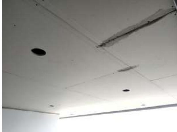
Figura 28. Fase de tapada en cielo raso del apartamento 1301.
