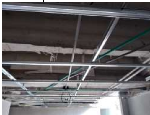
Figura 25. Instalación de perfilería de cielo raso, Fase de estructura del apartamento 1203.
