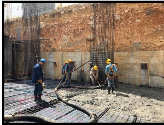
Figura 8. Fundida placa posterior edificio Millenium
