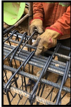
Figura 5. Instalación de refuerzo horizontal en viga de cimentación.
