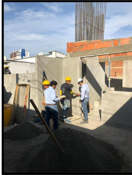
Figura 18. Realización de corte de obra (friso y mampostería).
