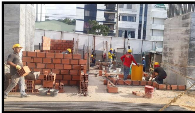
Figura 17. Levvantiendo de muros en mamposteria confinada.
