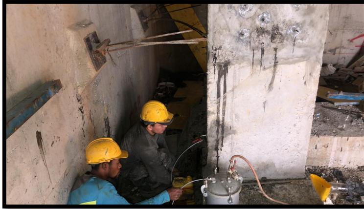
Figura 14. Proceso de inyección de pantallas
