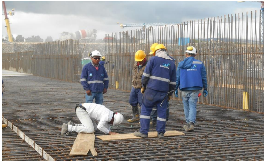
Ilustración 11. Inspección de Obra (Armadura)
