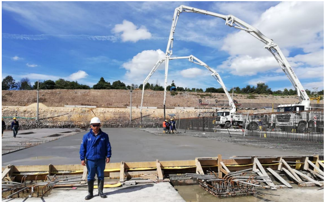
Ilustración 12. Inspección de Obra (Fundida Concreto)
