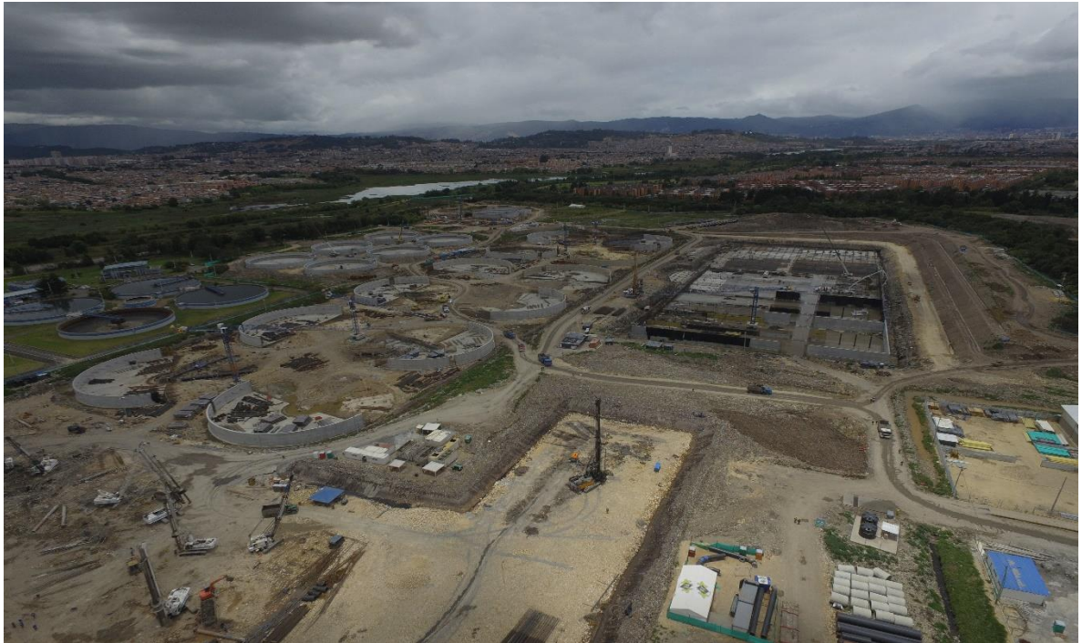
Ilustración 3. Avance de Obra
