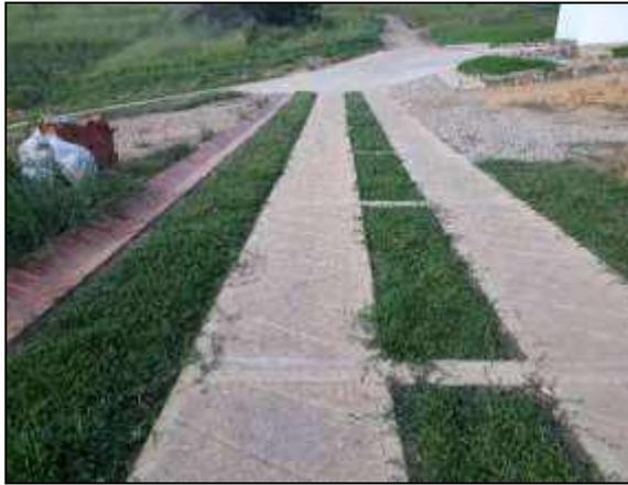
**FIGURA 149. Prado instalado en las placas huella**
