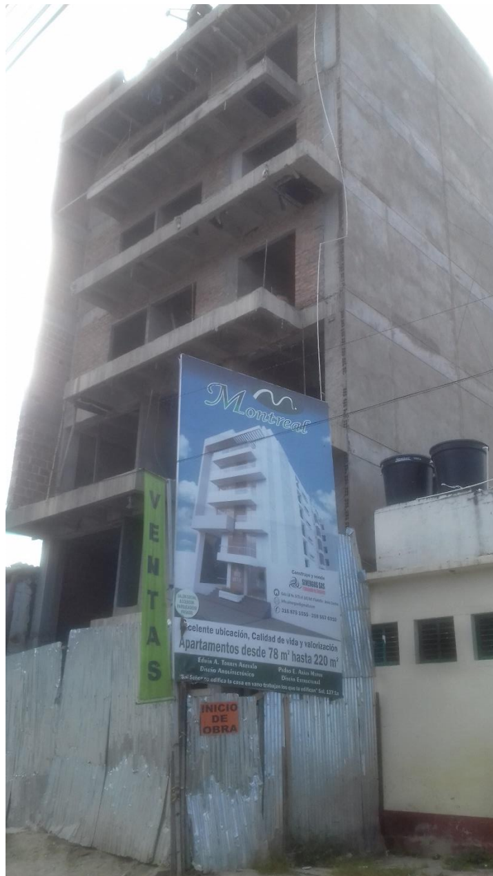
Imagen 13 Fachada proyecto MONTREAL.
