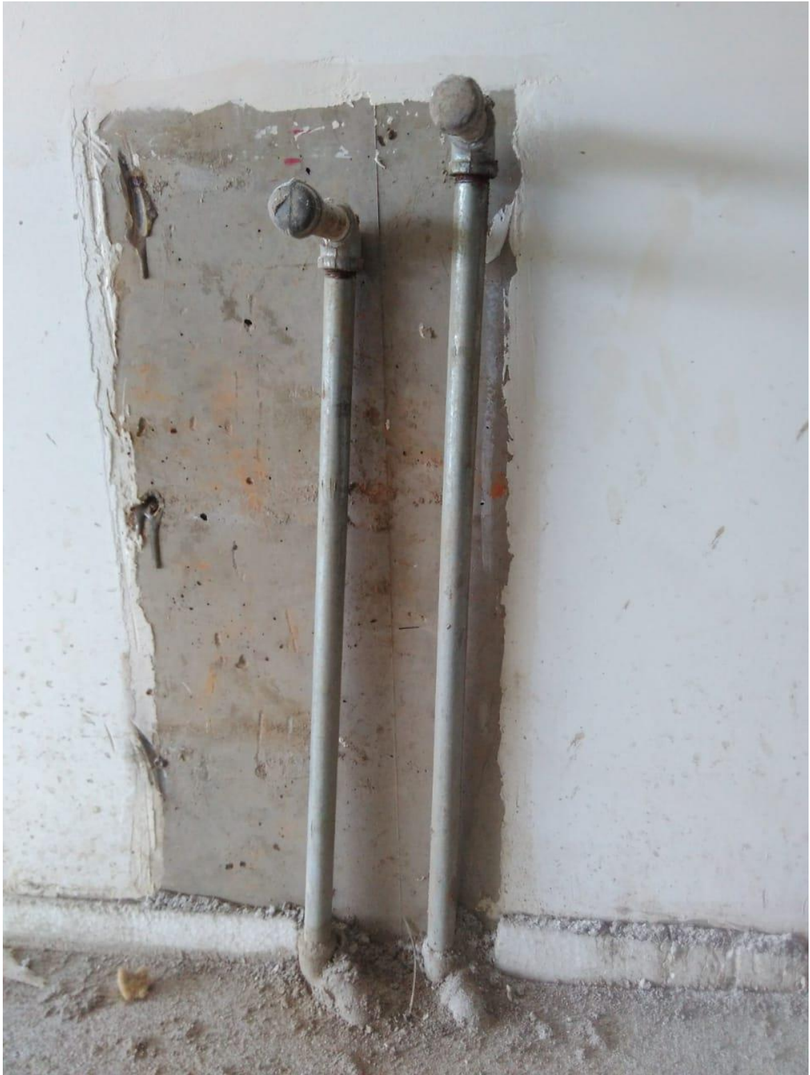
Imagen 18. Puntos de conexión de estufa y horno
