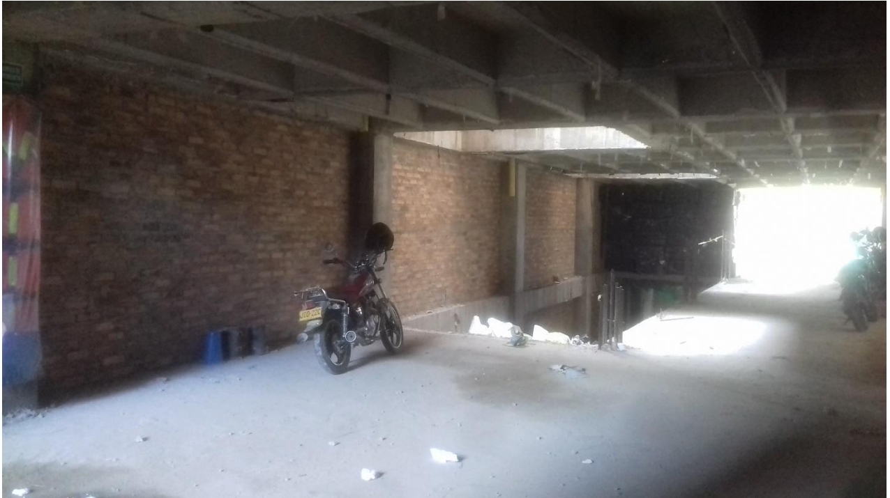
Imagen 14 Pared en la que se instalará el centro de medición.
