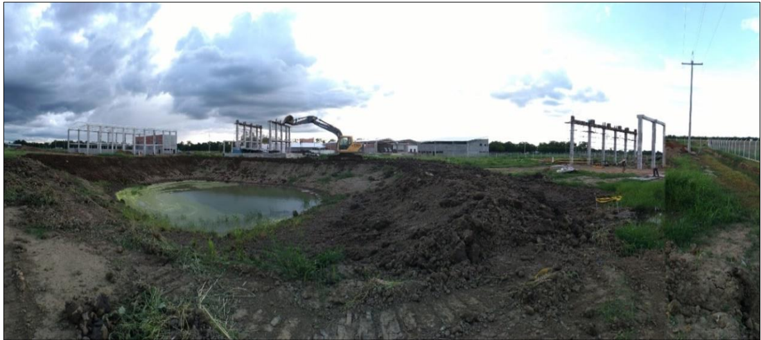
Figura 2. Estado actual del proyecto. Fuente: B&A Ingeniería y construcciones.
