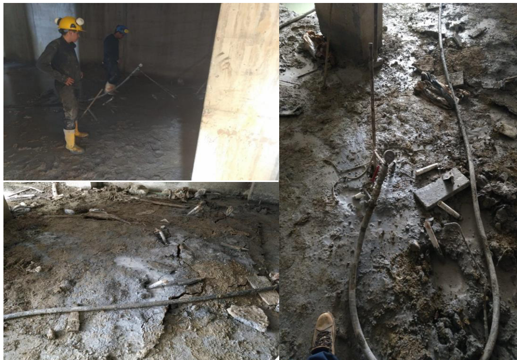
Ilustración 11. Llenado e inyección de lechada.
