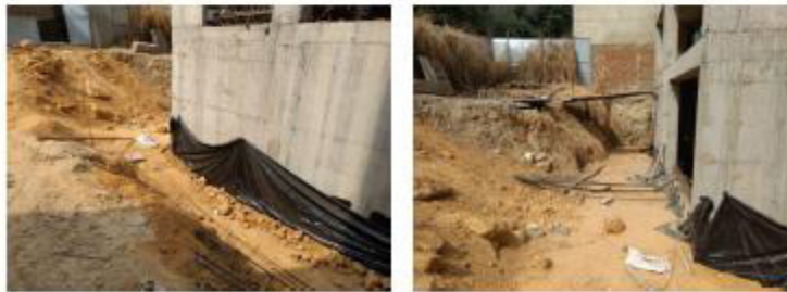
Ilustración 12. Relleno de la torre 3.
