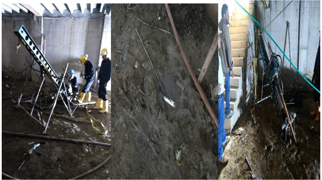
Ilustración 10. Proceso de perforación y llenado de lechada. T1
