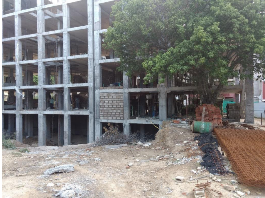
Ilustración 4. Pórtico de las torres 4 y 5.
