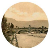
Construcción del puente Guayaquil
