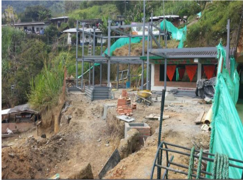
Figura 13. Construcción de la biblioteca de Pueblo Nuevo (antes), 2017.
