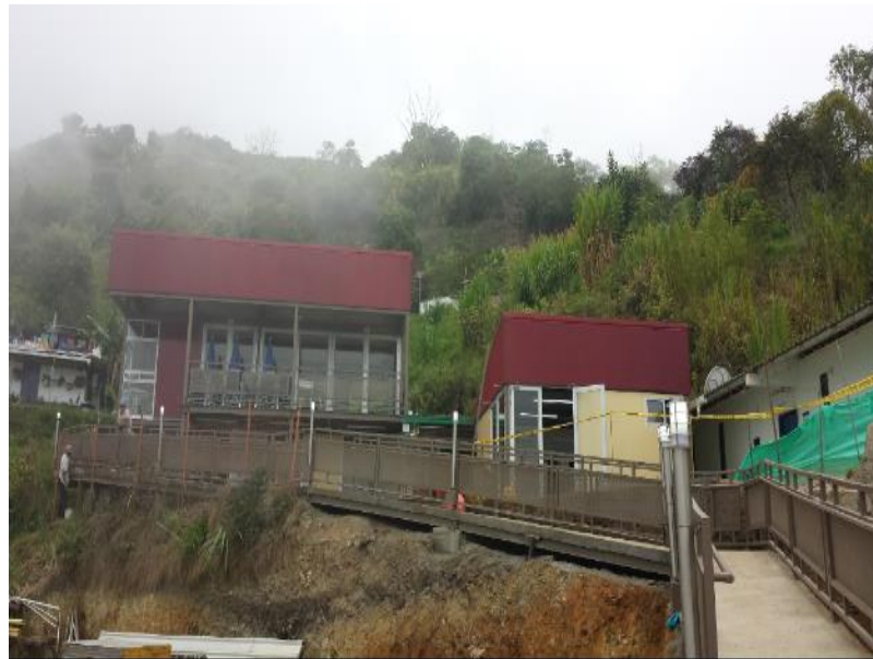
Figura 14. Construcción de la biblioteca de Pueblo Nuevo (después), 2018.
