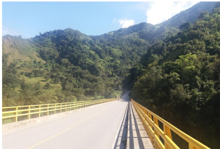
Figura 12. Puente Pescadero (después). Conexión entre Pueblo Nuevo y el casco urbano de Briceño, 2018.
