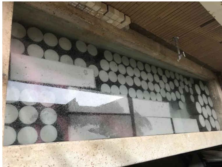
Ilustración 1. Curado del concreto.
