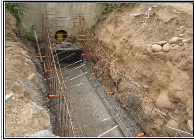
Fotografía 5. Canalización y Emisario
